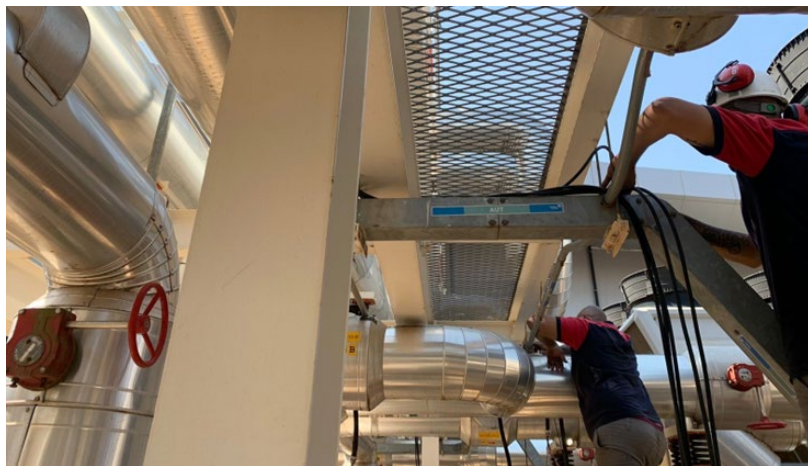
2 - Adequação de cabeamentos
