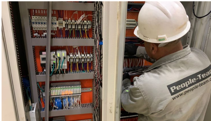
1 - Intervenções nos quadros de automação
