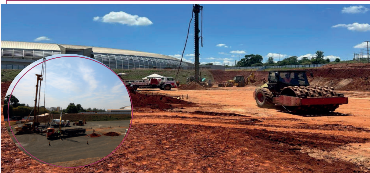
Figura 15: Obras de fundação do Orion
