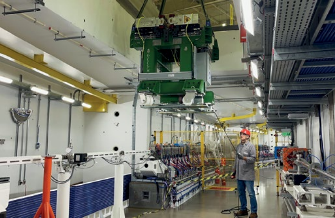
Processo de içamento do ondulador de polarização vertical da linha Cateretê. Hoisting process for the vertically polarizing undulator at the Cateretê beamline.
