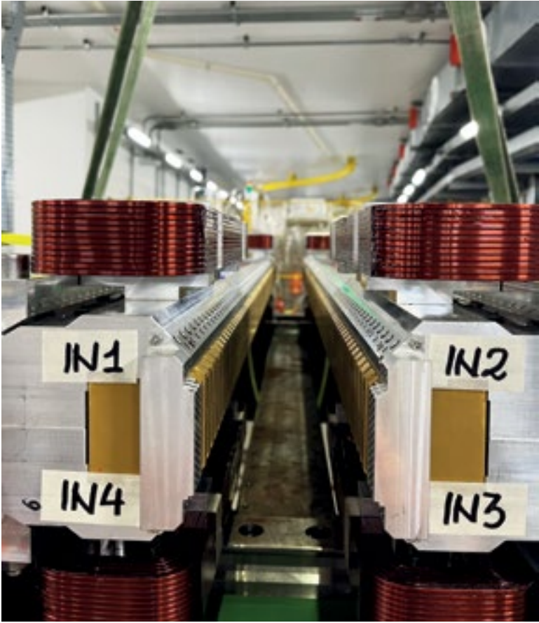
Cassetes de ímãs de um dos onduladores de polarização vertical instalados no anel de armazenamento do Sirius. Magnet cassettes for one of the vertically polarizing undulators installed in the Sirius storage ring.
