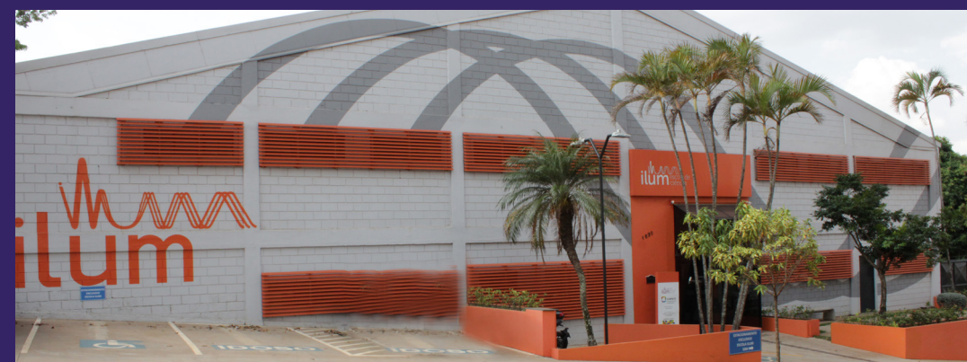
Imagens do prédio onde a primeira fonte de luz síncrotron do Hemisfério Sul começou a ser montada na década de 80. Edifício foi reformado para receber a sede da Ilum em 2022.
