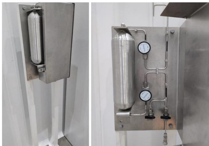
Na Figura 11 temos os flexíveis da tubulação de oxigênio com flange para conexão as válvulas dos espelhos M1 e M2.
