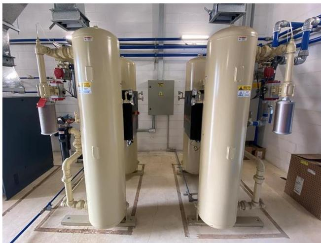
*Figura 2 - Secadores por adsorção*
