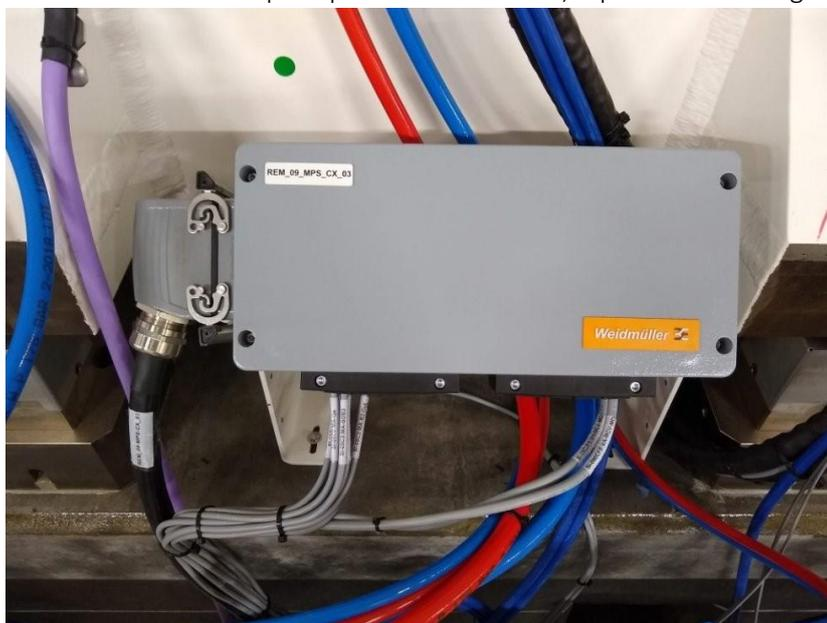
*Figura 1 – Sistema de cabeamento e nova caixa de passagem.*
