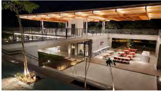
Vista superior da arquibancada
