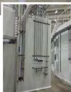
Figura 128: Painéis e racks de controle e automação, tubos de fluidos e régua de tomadas e tomadas industriais e os cabos dos equipamentos óticos instalados na área de transporte e no front-end.
