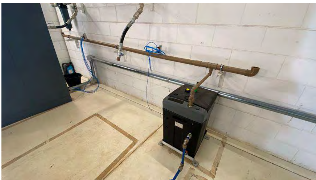
Figura 554: Sistema de drenagem dos condensados
