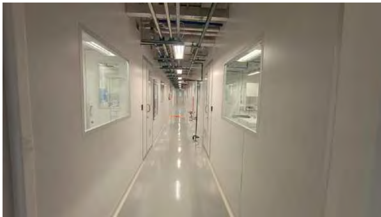
Figura 241. Corredor central da área laboratorial A1.
