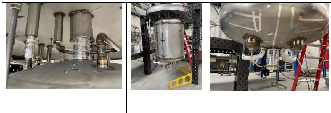
Figura 523 - Separador de fases de Nitrogênio em retrabalho na DEMACO
