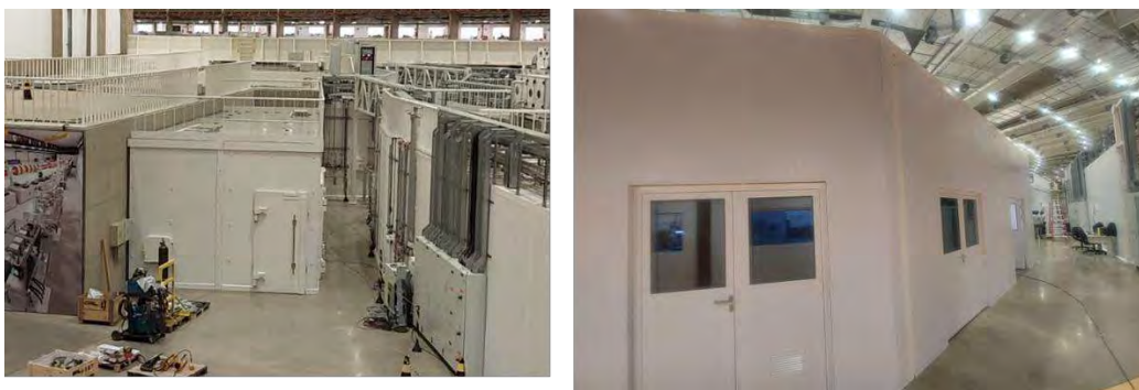
Figura 134: Cabana experimental (esquerda) e instalação completa das cabanas da linha de luz Jatobá no hall experimental.
