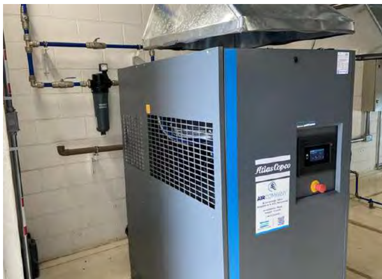
Figura 551: Compressor de ar comprimido n° 4
