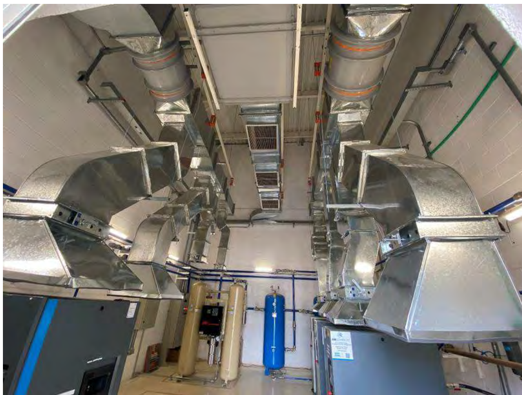
Figura 555: Novos exaustores e dutos de exaustão de ar quente
