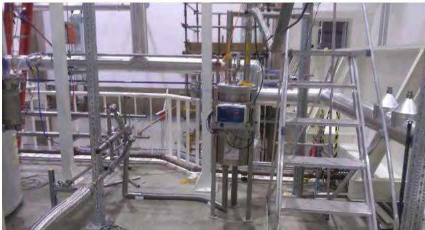
Figura 522: Separador de fases provisório montado
