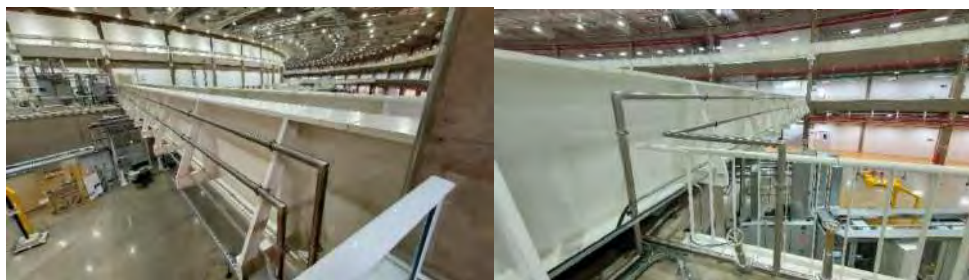
Figura 525: TL1A e TL3 instalados na passarela
