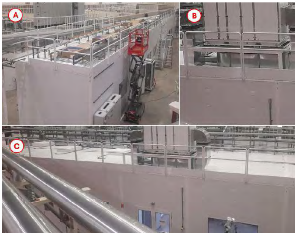
Figura 196: (A) Montagem do guarda corpo montado na linha TATU e (B e C) Guarda corpo da linha SAPE.
