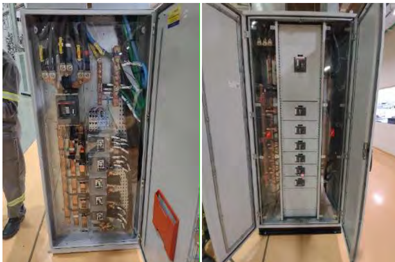
Figura 195: (Esquerda) Modelo de painel 220V antigo; (Direita) Modelo de painel 220V novo instalado
