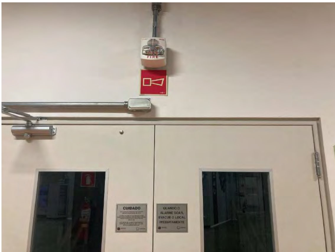
Figura 534: Audiovisual externo do CPD para indicação de acionamento do sistema de combate.
