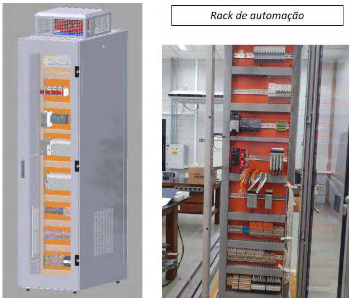
Figura 462: Rack contendo o sistema de intertravamento do acelerador. Projeto e fotografia do seu estado atual de montagem.
