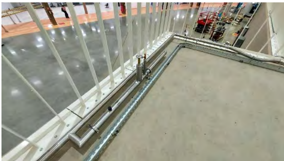
Figura 527: Picagem para linha de luz do sistema de distribuição de Nitrogênio
