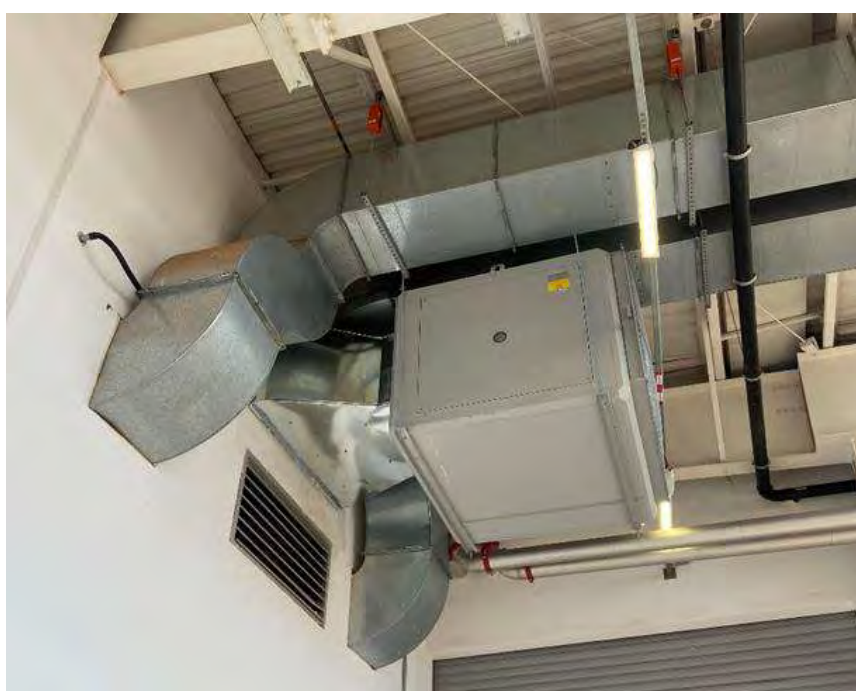
Figura 555: Novos exaustores e dutos de exaustão de ar quente
