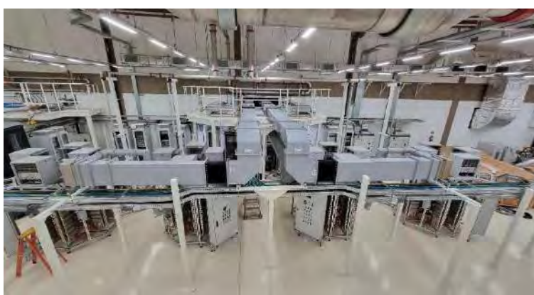
Figura 108: Finalização da ampliação do sistema de amplificadores para alimentar as cavidades supercondutoras
