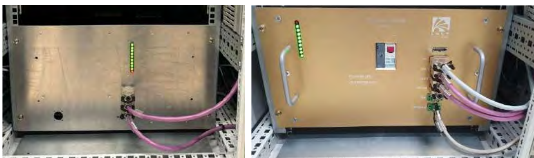
Figura 496: Foto do frontal antes (esquerda) e depois (direita) da instalação
