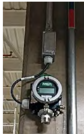
Figura 511: Sensor de oxigênio instalado no eixo D
