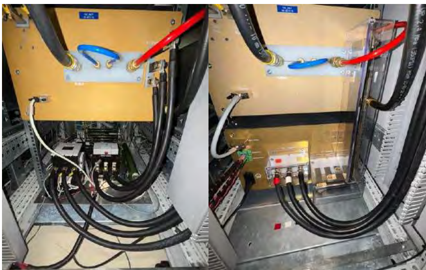
Figura 495: Fotos da traseira do módulo antes (esquerda) e depois (direita) da instalação
