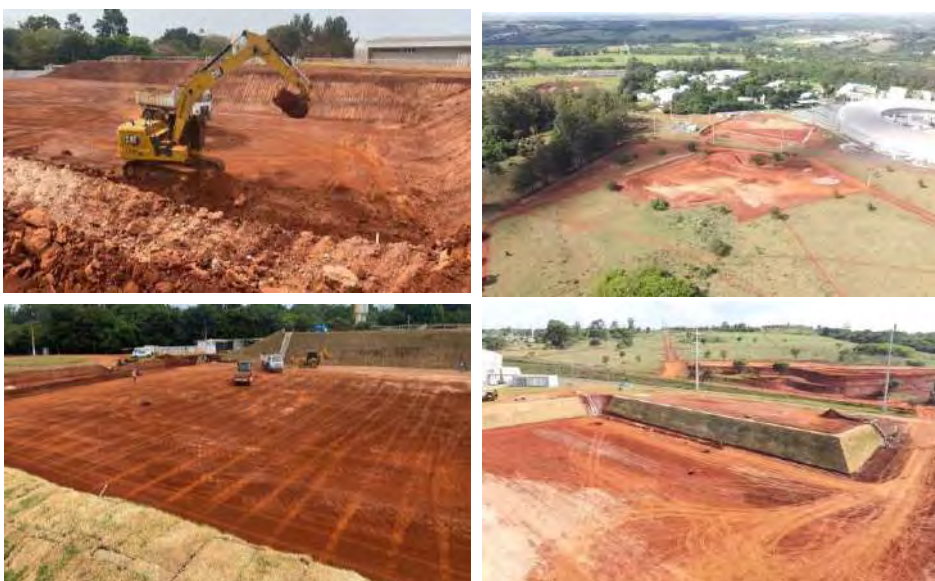
Figura 563: Operação de corte, terraplanagem e compactação do platô do subsolo do Projeto Orion
