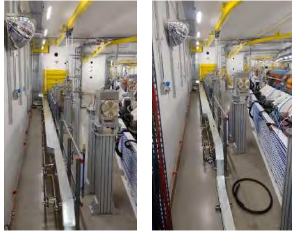
Figura 111: Instalação da infraestrutura básica de utilidades e suportação de componentes do Fron-end das linhas Timbó e Hibisco do Órion.
