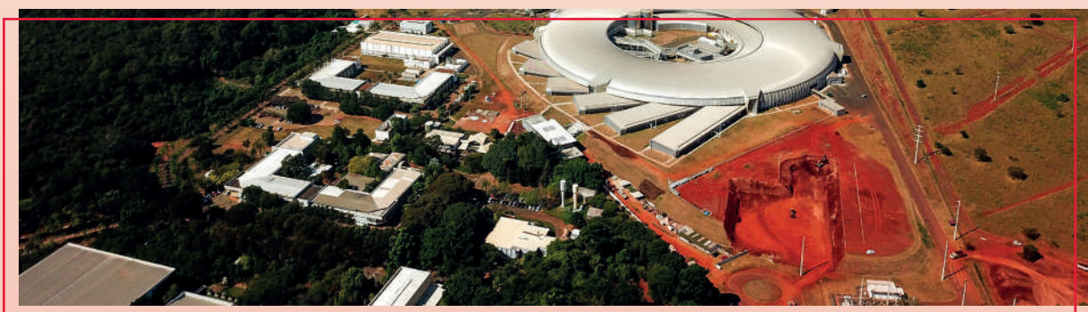
Imagem aérea de maio de 2024, onde mostra a etapa de escavações do terreno onde está sendo construído o Orion (Créditos: Divulgação/CNPEM)
