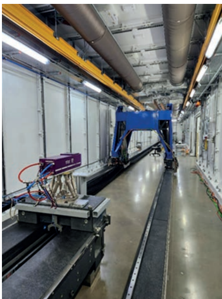
Figura 147 - Vista da microestação na cabana experimental da MOGNO, com o pórtico (estrutura azul) recém-instalado.
