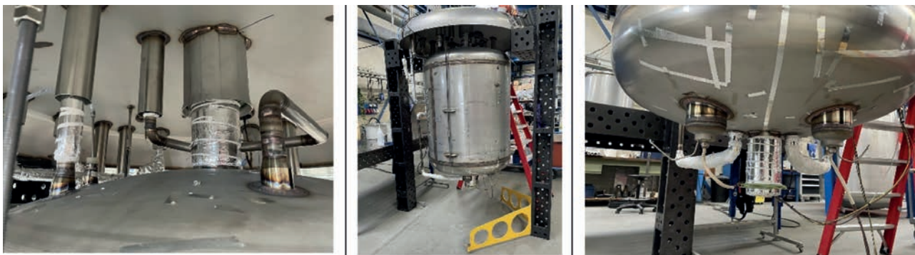
Figura 98 – Separador de fases de Nitrogênio em retrabalho na DEMACO
