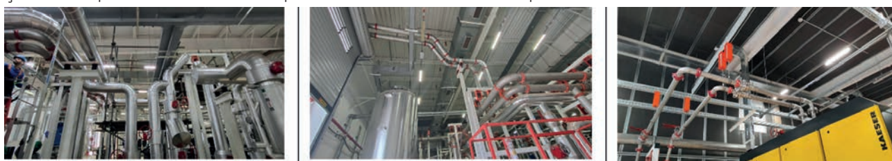
Figura 89. Montagem do Circuito C2 na Casa de Bombas 1
