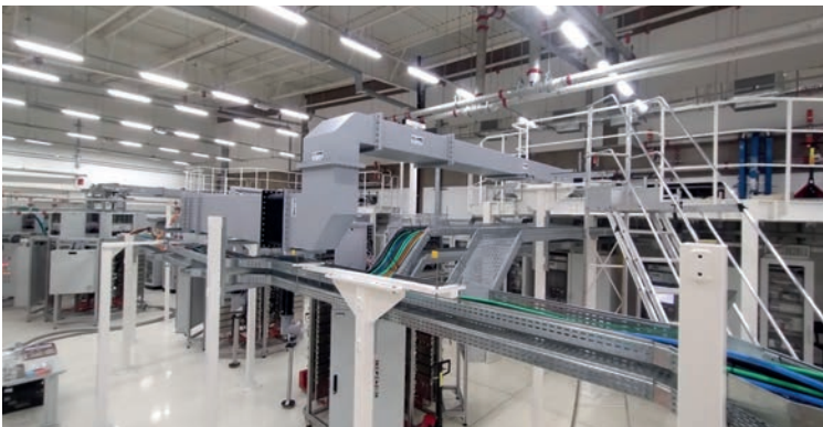
Figura 113: Instalações RF em andamento na sala para receber as novas cavidades de RF supercondutoras.
