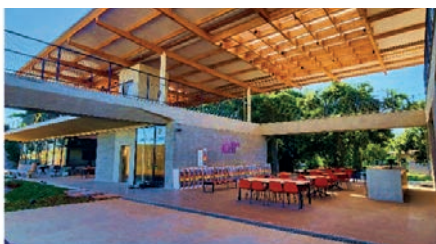
Foto de obra – Pátio central
