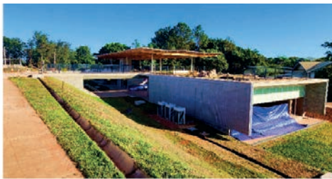
Foto de obra – Vista no nível do Sirius
