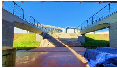
Foto de obra – Vista da arquibancada
