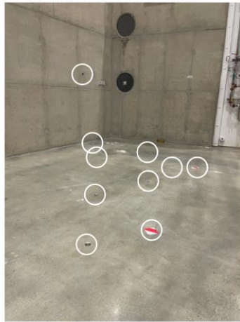
Instalados alvos de referência
