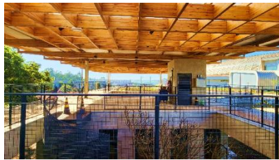
Foto de obra – Vista do terraço
