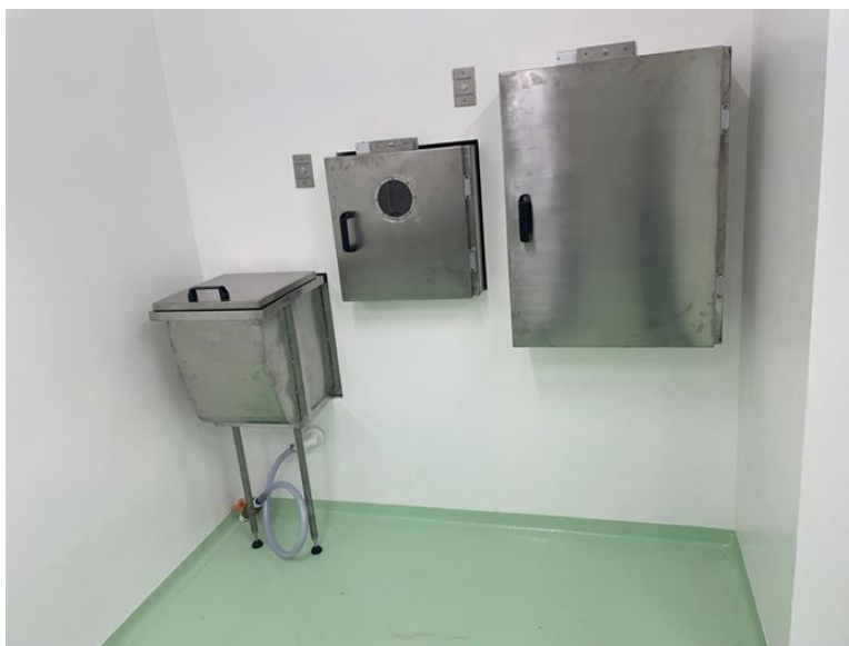
Figura 4 –Instalação do dunk tank , pass thru e autoclave.
