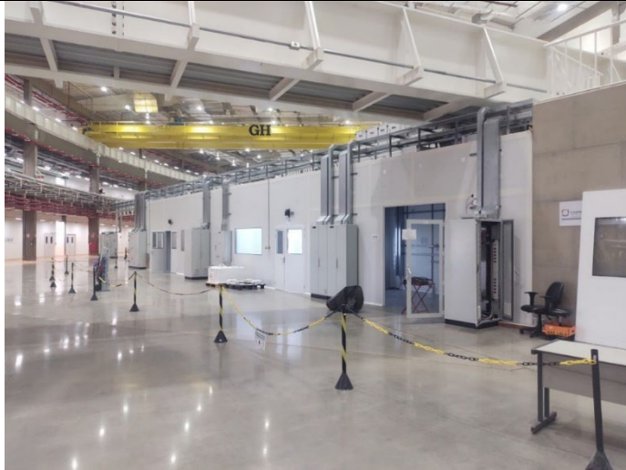
Figura 3: Paineis posicionados aguardando passagem do cabeamento.
