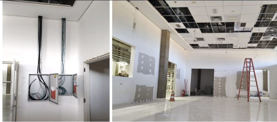
Figura 5: Adequações de portas, visores, painéis
