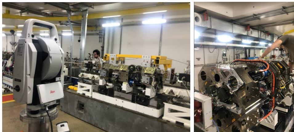
Figura 334. Alinhamento ondulator Delta 525 da linha de luz sabi 
