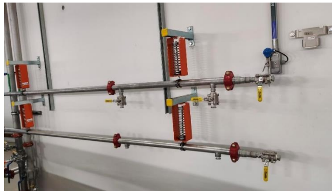
Figura 379. Instalação do circuito de processos dentro da blindagem.
