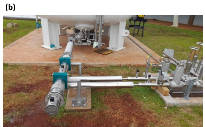
Figura 367. (a) Instalação das linhas do TL1A e TL3 na parte externa do prédio. (b) Instalação da linha isolada a vácuo entre tanque e linhas da DEMACO
