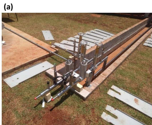
Figura 367. (a) Instalação das linhas do TL1A e TL3 na parte externa do prédio. (b) Instalação da linha isolada a vácuo entre tanque e linhas da DEMACO
