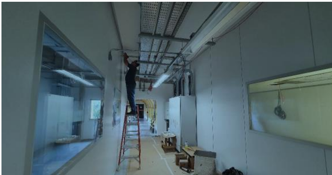
Figura 190. Reforma do Setor A1 - visão geral
