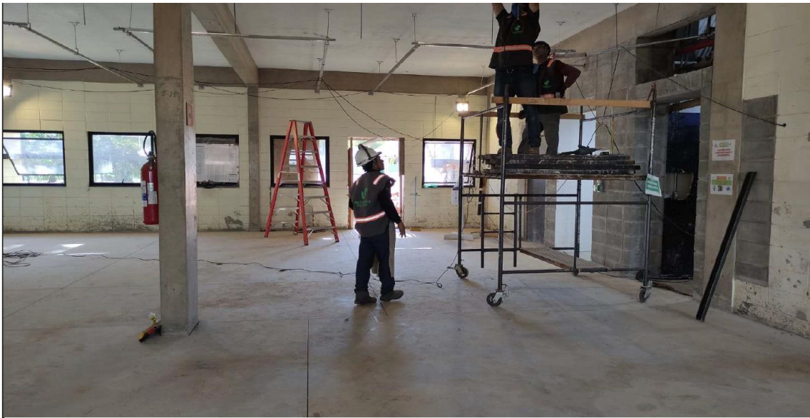
Figura 188. Montagem da infraestrutura aérea
