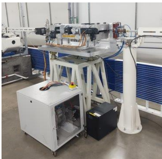
Figura 338. Ondulador PAPS instalado no trecho da linha Sapucaia.
