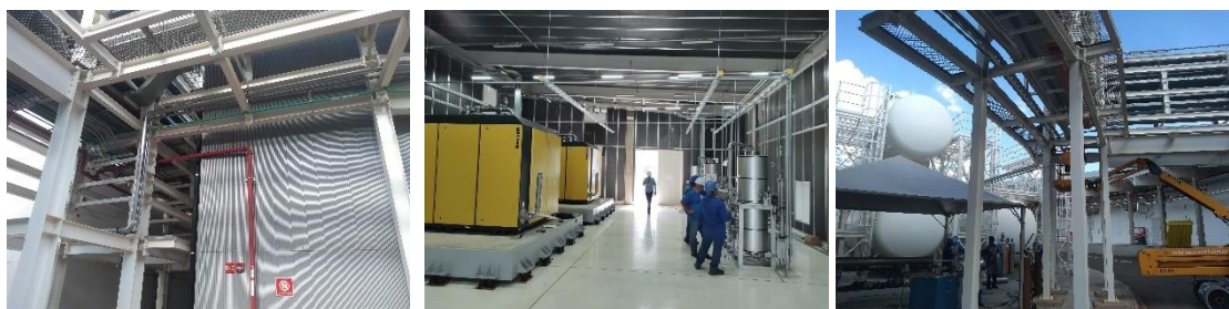
Figura 381. Montagem das tubulações nas áreas do pipe rack, sala de compressores e tanques de hélio.
