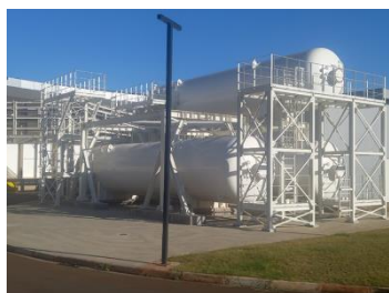
Estrutura Metálica dos tanques de He
