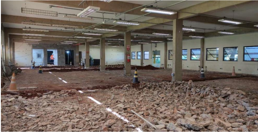
Figura 390. Demolição do piso Setor A1
