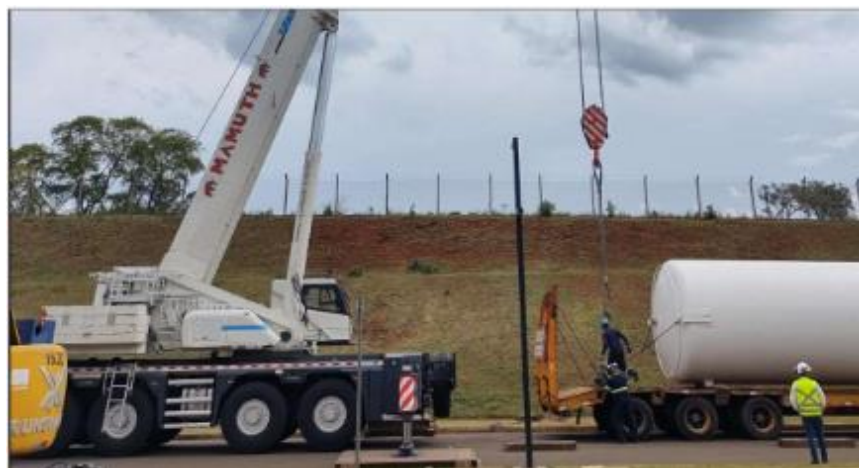
Figura 365. Içamento do tanque para remoção do caminhão
