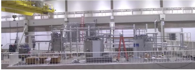
Figura 378. Equipamentos e transfer lines instalados
