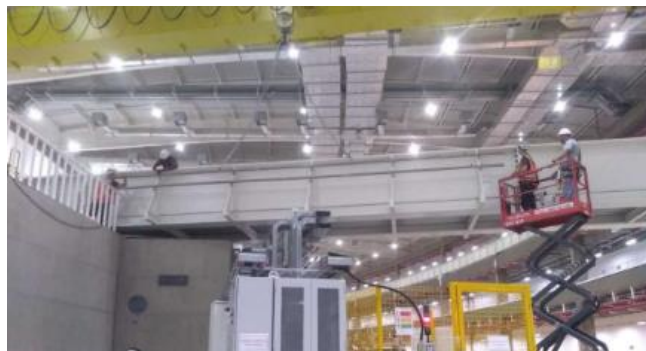
Figura 368. Montagem do TL3 e TL1A na passarela do eixo 20
