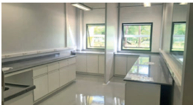
Setor A1 - instalação de mobiliário nas instalações destinadas à Engenharia de Tecidos
