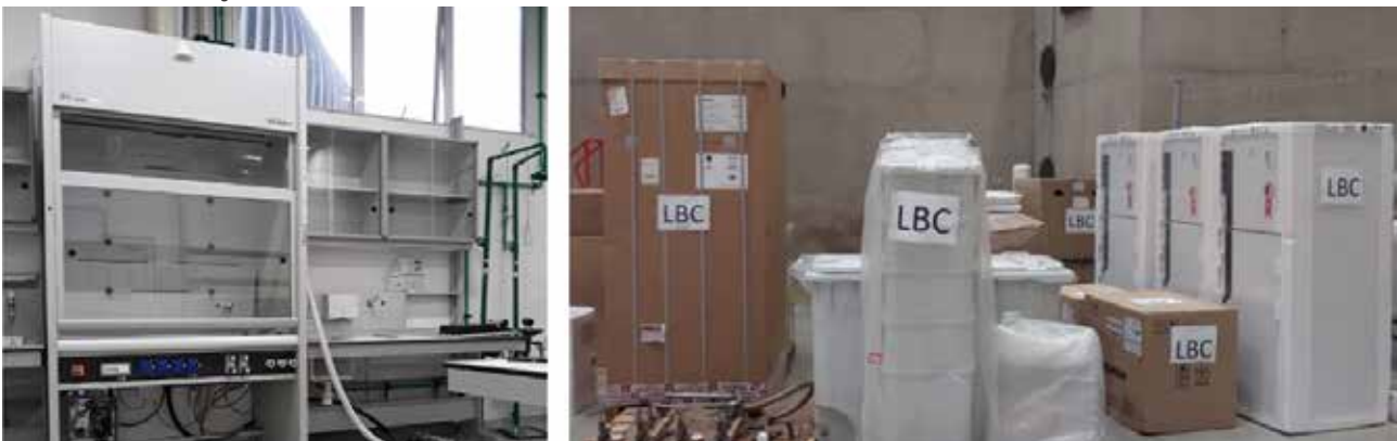
Figura 94: Montagem do mobiliário e instalações de elétrica e hidráulica (esquerda); os equipamentos armazenados no hall do Sirius para futuras instalações no LAB (direita).
