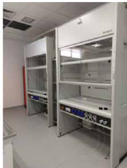
Figura 90: Montagem do mobiliário e instalações de elétrica e hidráulica (esquerda); capelas de exaustão (direita).
