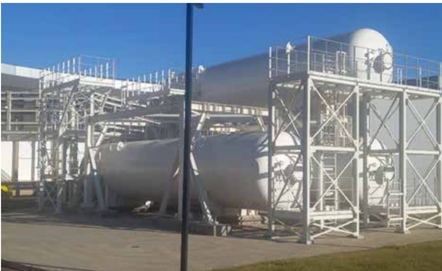
Figura 49 - Estrutura metálica e tanques de Hélio instalados
