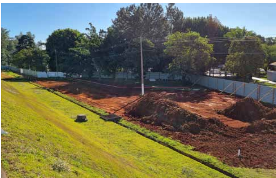
Figura 102 - Foto das atividades iniciais para a construção do Centro de Vivência Ilum
