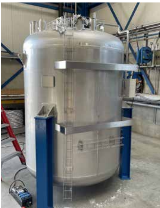
Figura 43 - Separador de fases de Nitrogênio
