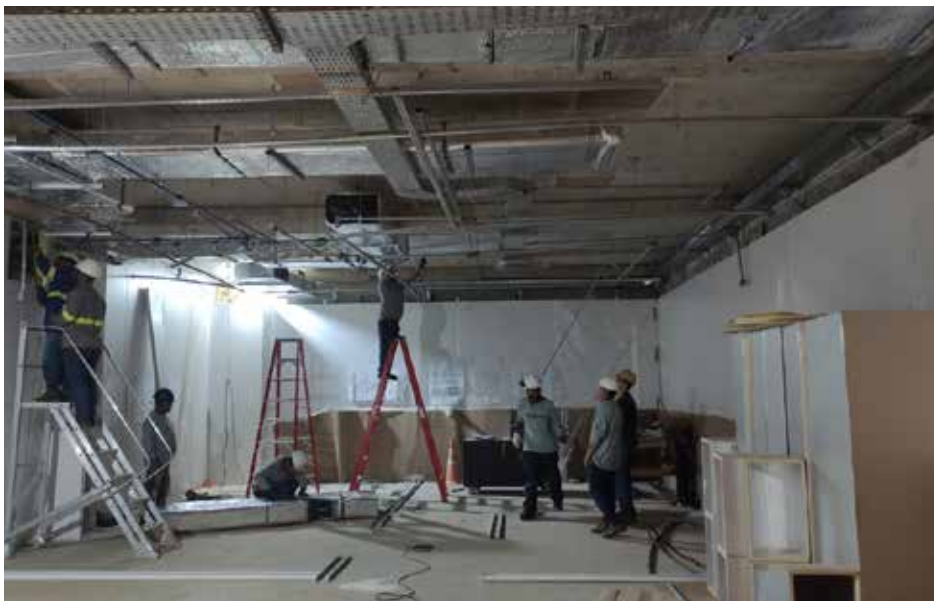
Figura 99 - Foto da construção do laboratório NB3.
