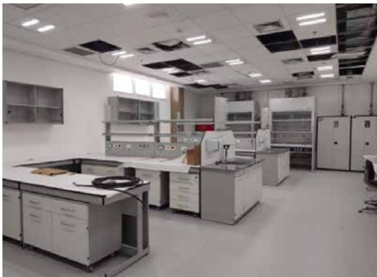
Figura 90: Montagem do mobiliário e instalações de elétrica e hidráulica (esquerda); capelas de exaustão (direita).
