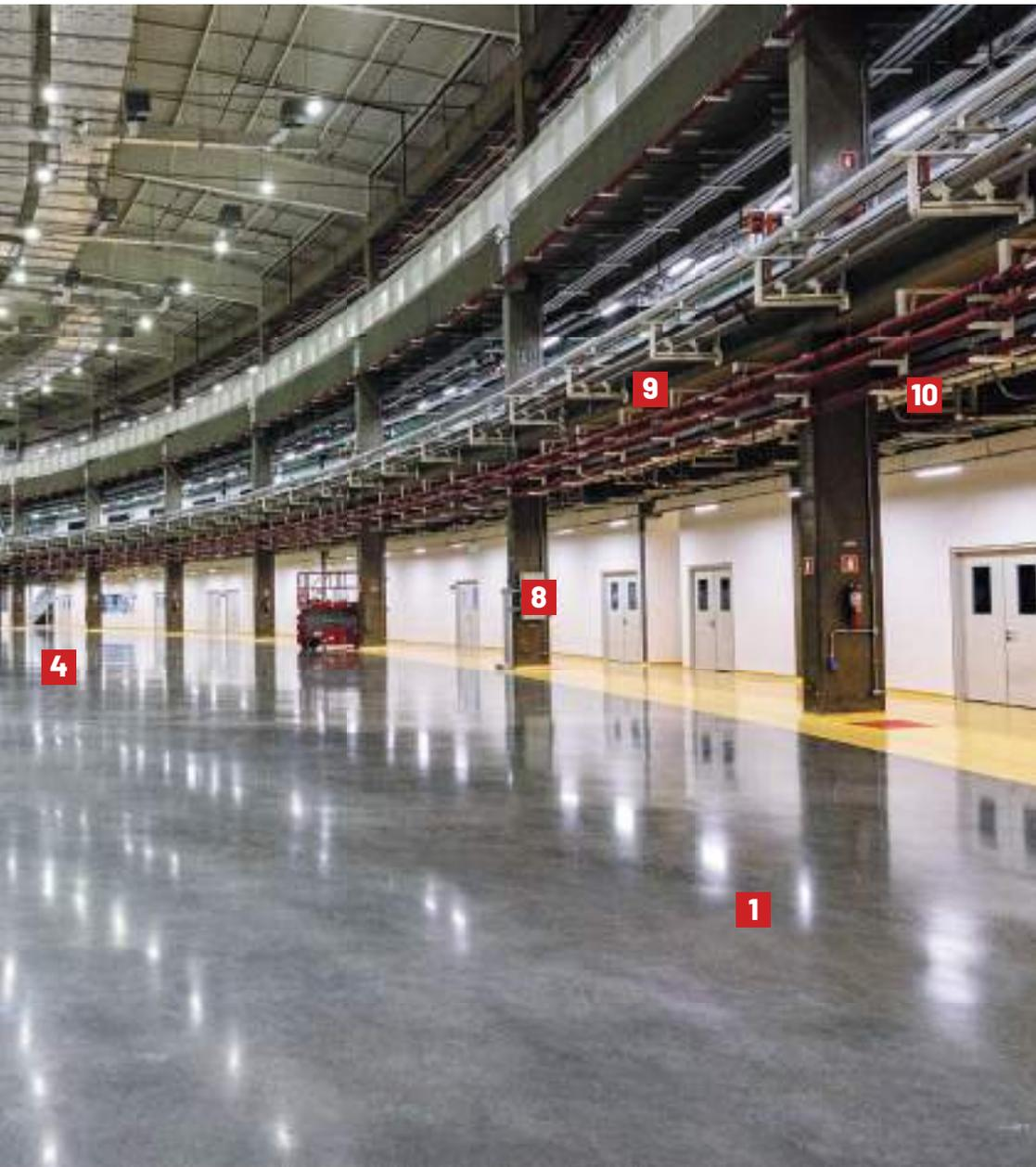
**3.** Os pisos que suportam a área dos aceleradores e a região das linhas de luz são feitos em concreto armado, com 90 e 60 centímetros de espessura, respectivamente.
