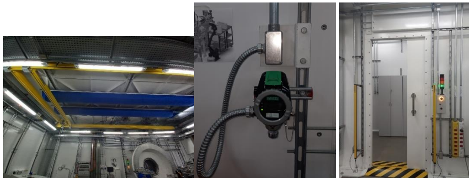
Figura 53 - Foto do teto do Hutch experimental da linha Paineira mostrando a ponte rolante; sensor de O 2 instalado no Hutch Experimental; ao lado direito da porta é mostrado as lâmpadas multicoloridas, o botão de procura e botão de emergência.
