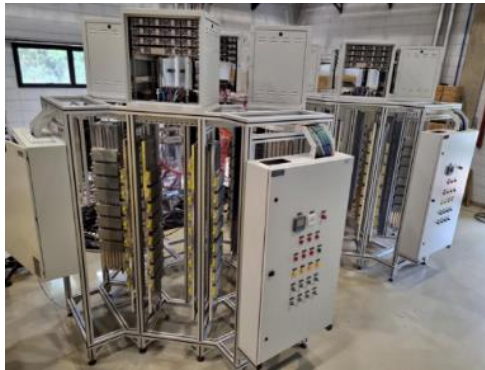
Figura 10 - Dois novos amplificadores em fase de montagem
