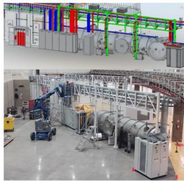
Figura 72 - Comparação instalações físicas e projeto 3D
