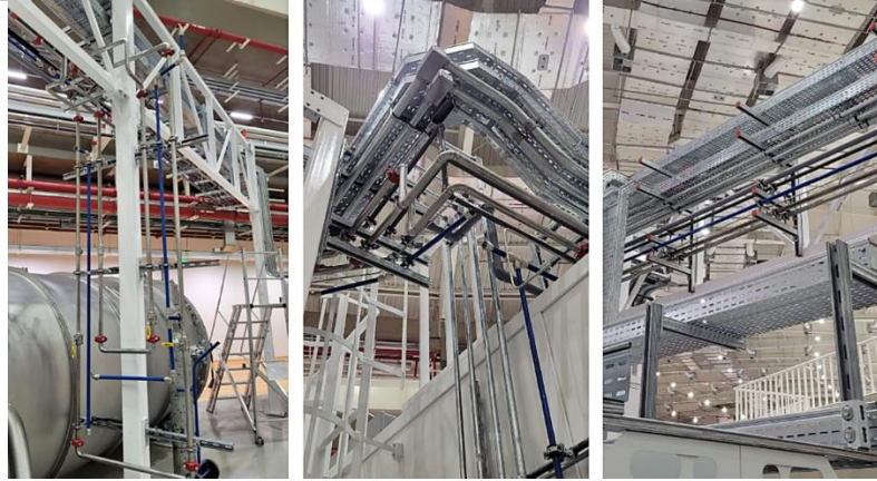
Figura 71 - Infraestrutura de Utilidades pipe-line's, cabanas A e B
