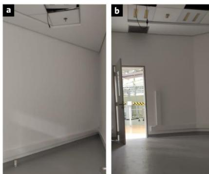
Figura 48 - Estado atual da execução do projeto com destaque para piso já concluído e com as devidas soldas realizadas, e para o teto, onde temos as placas que compõem o forro instaladas.
