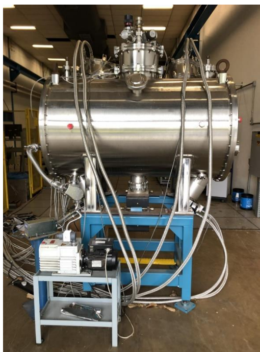
Figura 383 – SCW instalado na sala de fontes da UVX.
