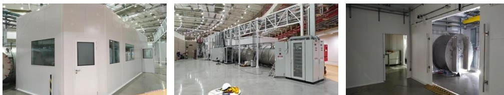
Figura 139. Status atual de construção da linha Sapucaia, onde há as instalações de infraestrutura da linha, como passagem de água, eletricidade e cabeamento de um modo geral, com destaque para a região interna das cabanas da linha.
