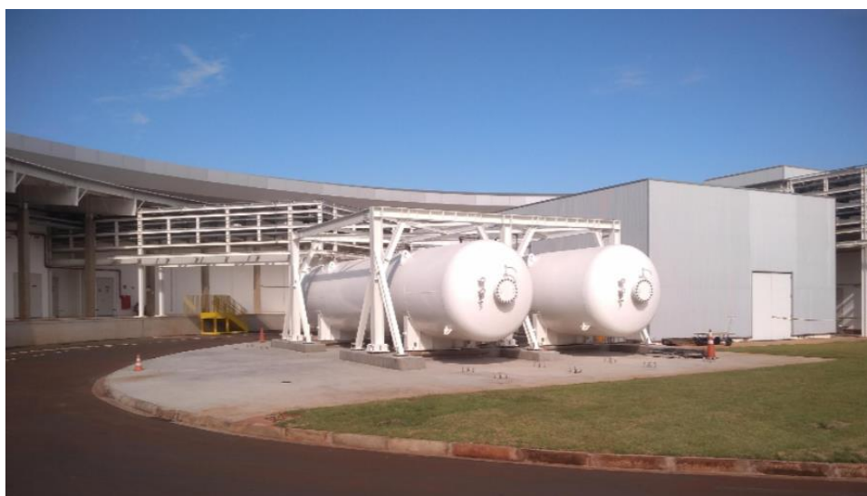
Figura 441 – Estrutura metálica montada para receber o terceiro tanque
