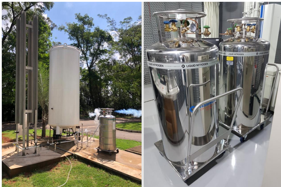
Figura 363. Imagem à esquerda: novo tanque de nitrogênio líquido do LNNano (2.500L) abastecendo um dewar de 240L. Imagem à direita: novos dewars de 300L para abastecimento dos criomicroscópios.
