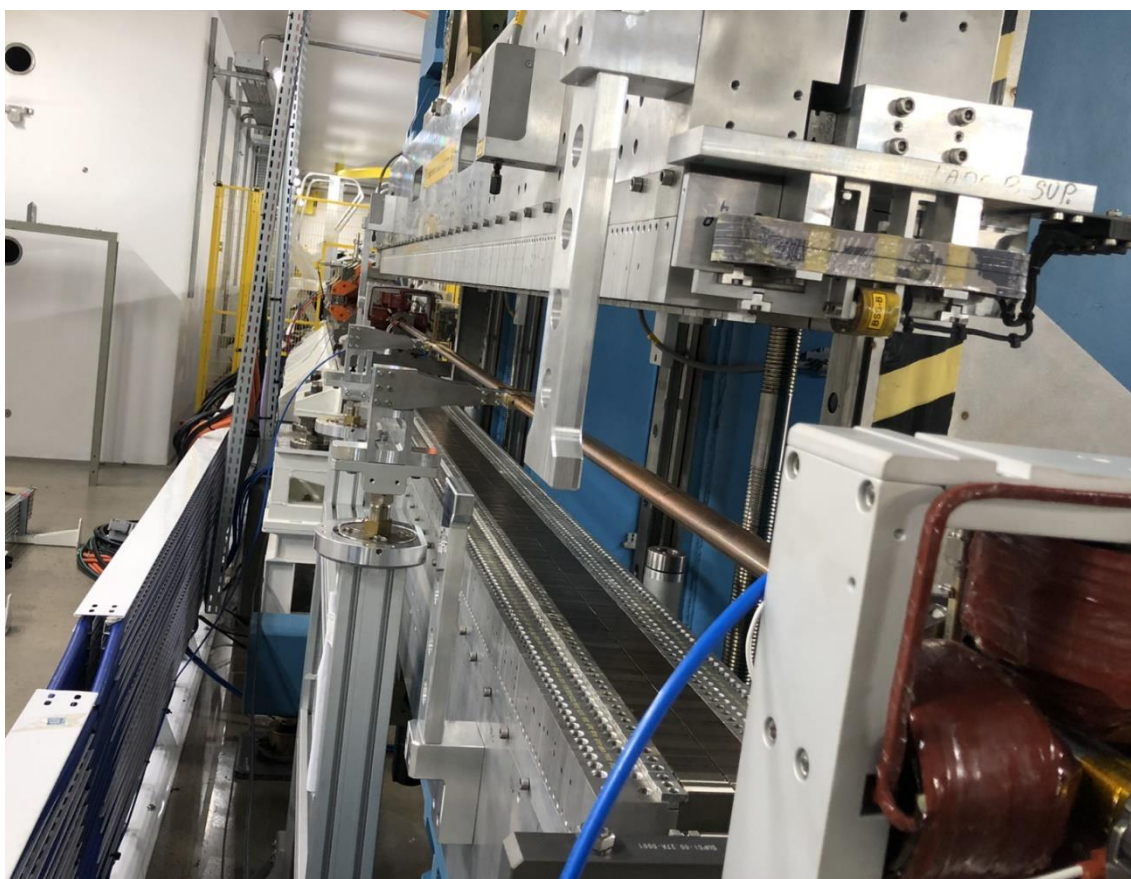
Figura 426 - EPU do UVX instalado no trecho 10 do anel de armazenamento.
