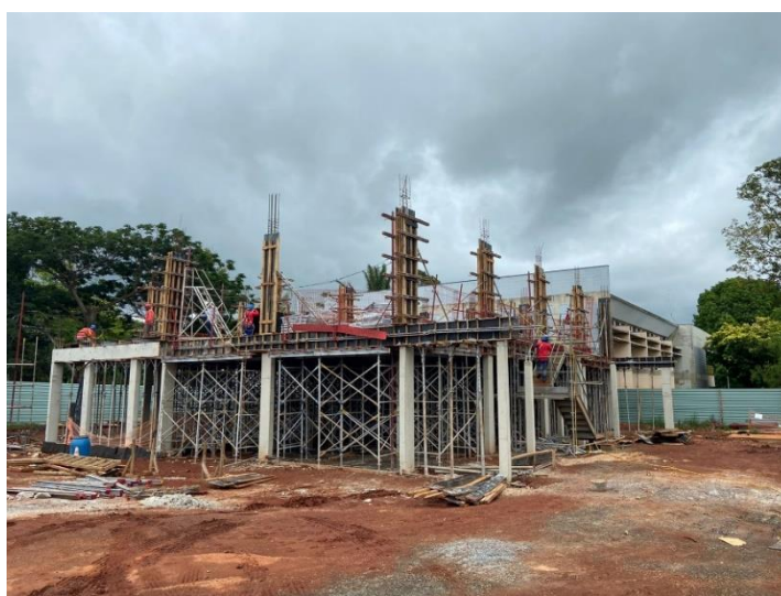
Figura 479 – Obra expansão LNBio em andamento (Setor E)
