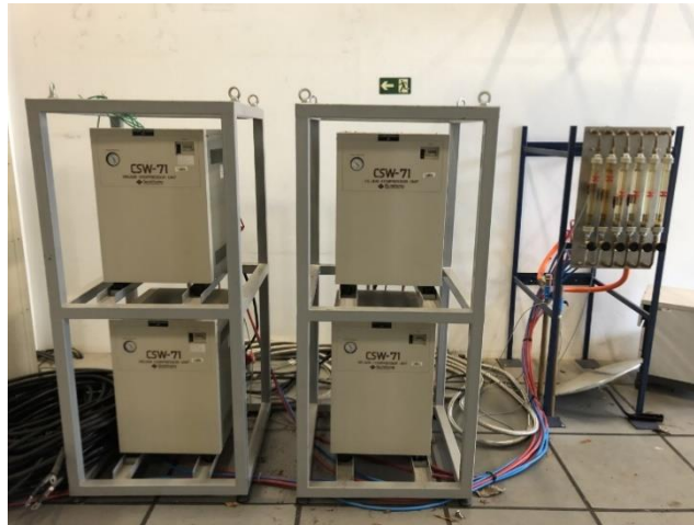
Figura 385 – Compressores de hélio, manifold e rotômetros da água de resfriamento.
