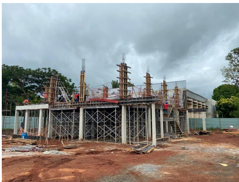
Figura 276 – Andamento da obra do laboratório NB3 como expansão do LNBio (Setor E)
