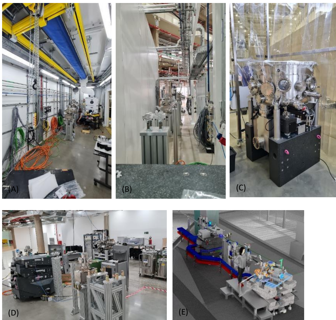
Figura 126: Avanço da instalação de componentes - (A) no interior da cabana óptica; (B) na linha de transporte para as estações; (C) integração de controle do monocromador PGM; (D) no entorno da estação PEEM. (E) Projetos de infraestrutura técnica e base de granito para PEEM em fase estágio avançado de elaboração.
