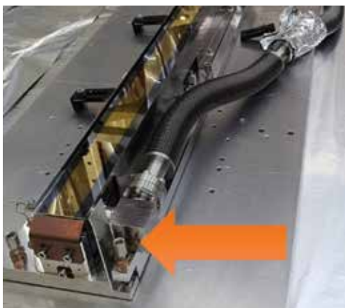
Figura 30: Espelho PGM. A seta indica a região do vazamento
