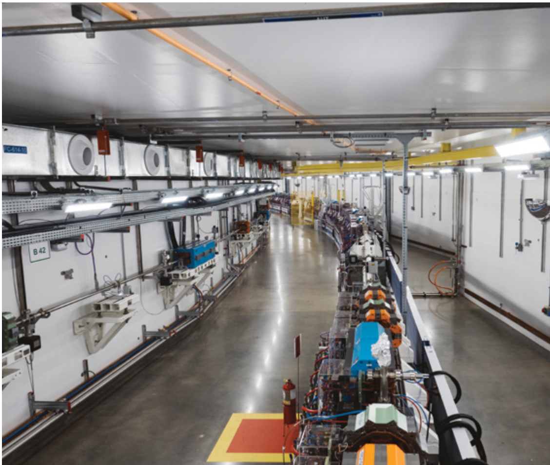
Túnel dos aceleradores de elétrons do Sirius, que está em fase de comissionamento, ou seja, testes e ajustes para que o equipamento possa entrar em operação, produzindo luz síncrotron de quarta geração. Electric accelerator tunnel from Sirius, which is in the commissioning phase, therefore under tests and adjustments to enter into operation, producing fourth-generation synchrotron light
