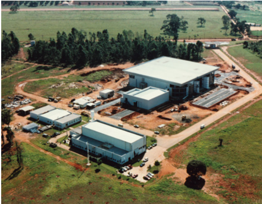
Imagem aérea do campus do CNPEM à época da construção da fonte de luz síncrotron UVX. Aerial image of CNPEM campus during the construction of the UVX synchrotron light source.
