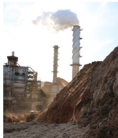
Toneladas de bagaço sendo convertidas em eletricidade. Tons of bagasse being converted into electricity.
