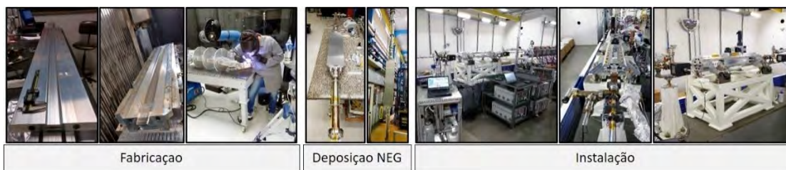
Figura 150. Fabricação e instalação das câmaras de vácuo especiais para os Onduladores planares.
