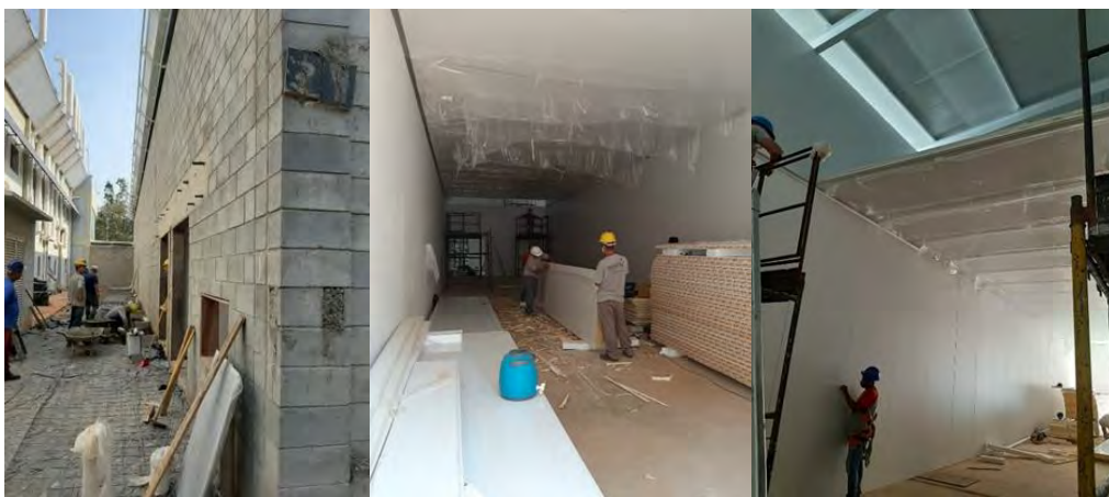
Figura 131. Obras durante o período de quarentena
