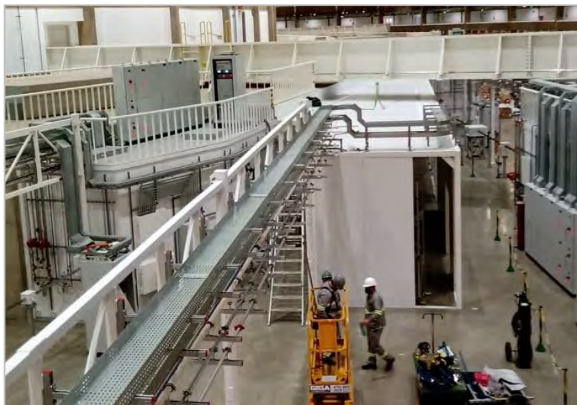
Figura 16. Instalação das cabanas de isopainel da linha IMBUÍA, entre as linhas CATERETÊ (à esquerda) e CARNAÚBA (à direita).
