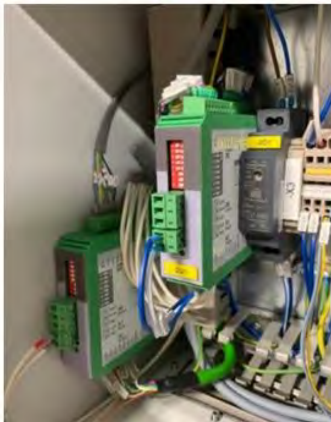
Figura 178. SERIALxxCON adaptada para leitura do encoder no trecho SI-09 e splitter adicional no painel.
