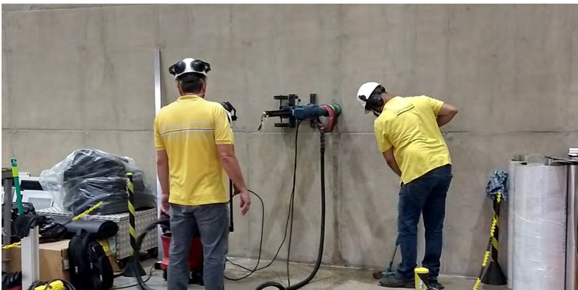
Figura 19. Execução furação da blindagem de concreto para extração do feixe infravermelho da linha IMBUIA.
