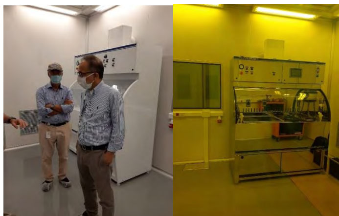
Figura 132. Instalação já pronta e recebendo equipamentos.
