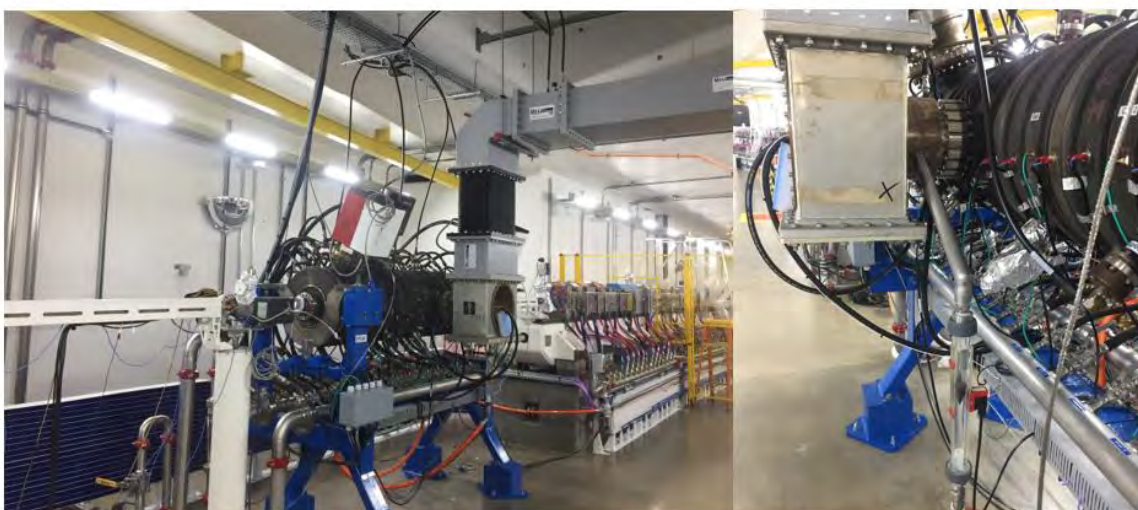
Figura 181. (Esq) A potência de até 120 kW gerada pelos amplificadores é transmitida por guias de onda até a cavidade. Ambos precisam ser cuidadosamente condicionados. (Dir) Transição entre o guia de onda retangular e o acoplador.
