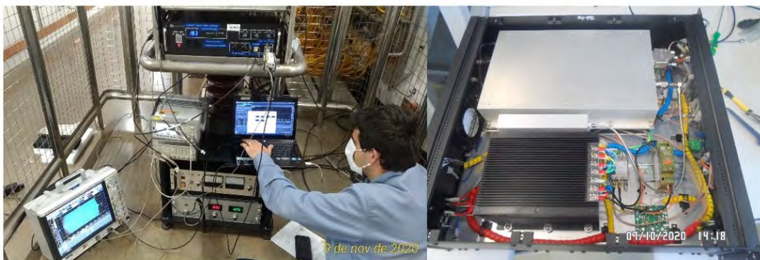
Figura 197. (Esq) Medidas no canhão de elétrons com a nova gaveta RF 500 MHz/600 Watts. (Dir) Detalhe da montagem interna da gaveta após as modificações.
