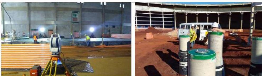
Figura 41: Esquerda: equipe do LNLS participando da verificação do nivelamento das juntas metálicas usadas como referência para o nivelamento do piso do acelerador. Direita: pilar central do prédio do Sirius e três pilares auxiliares (mais baixos), já com as placas de encaixe dos aparelhos instaladas.
