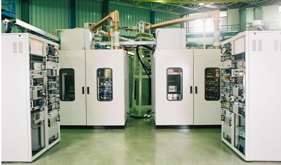
*Figura 1: As duas estações de potência do novo sistema de RF.*
