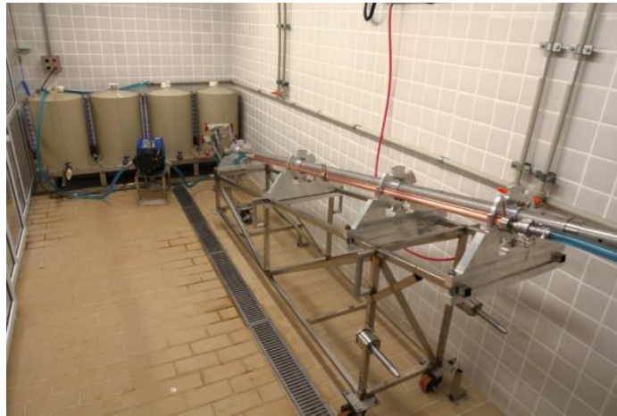
Figura 2.57: Equipamento de limpeza/decapagem das câmaras de cobre do Sirius
