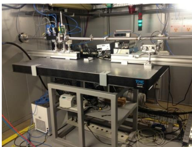
Figura 2.23. (Acima) Projeto da instalação da mesa óptica (em vermelho) na cabana experimental da linha XDS e (Abaixo) foto do equipamento já instalado, durante experimentos.
