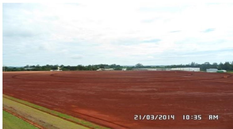
Figura 2.58: Terraplenagem do Terreno do Sirius
