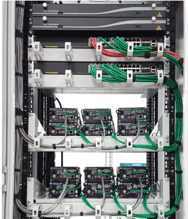
Figura 74. Rack do sistema de controle
