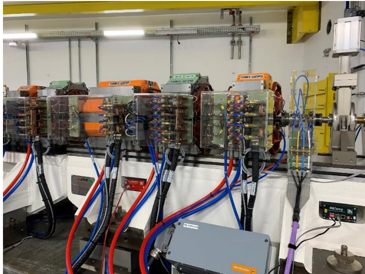
Figura 72. Um dos berços do Anel de Armazenamento, contendo eletrônicas de monitoramento de temperatura (MBTemp) e contadoras (CountingPRU)
