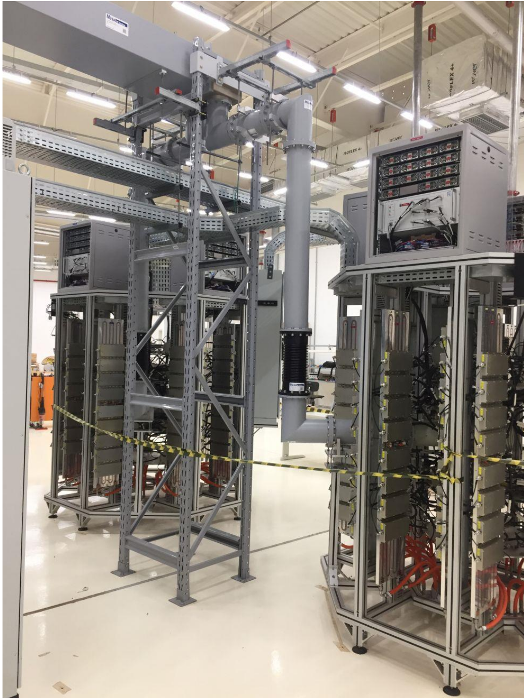
Figura 80. Detalhe da combinação das duas torres de 60 kW do sistema de RF do anel
