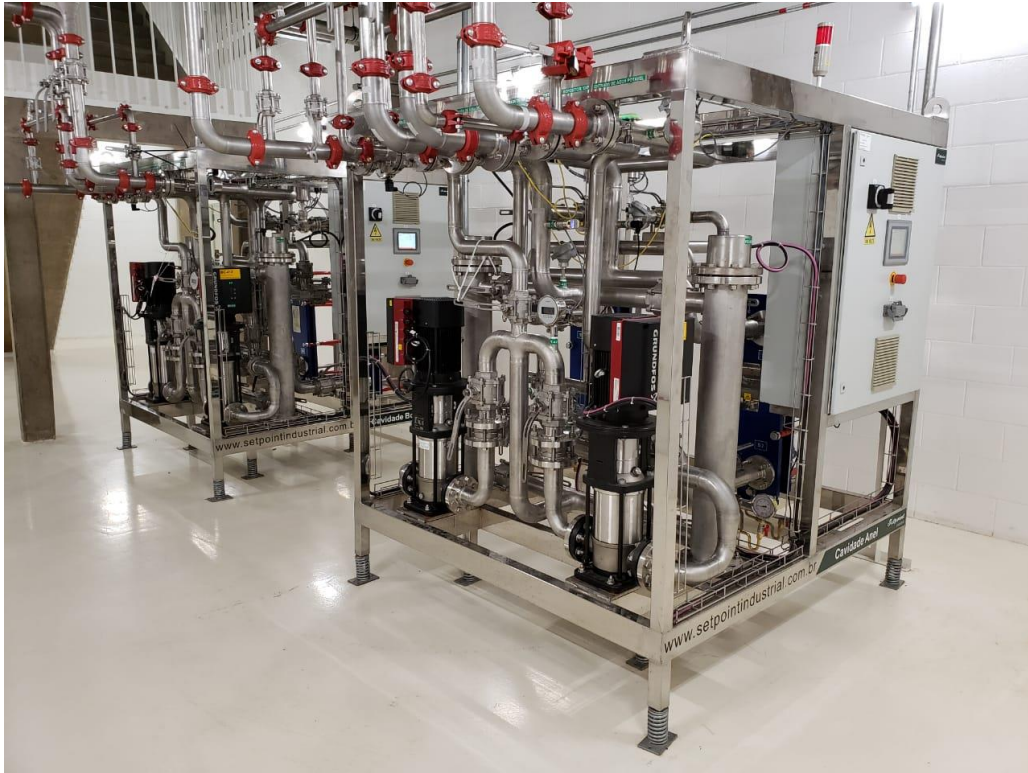
Figura 86. Termorreguladores das cavidades de RF do anel e do booster. As cavidades devem ser mantidas na sua temperatura de operação, com uma estabilidade de \pm 0,25^{\circ}\text{C} , para qualquer potência em que opere
