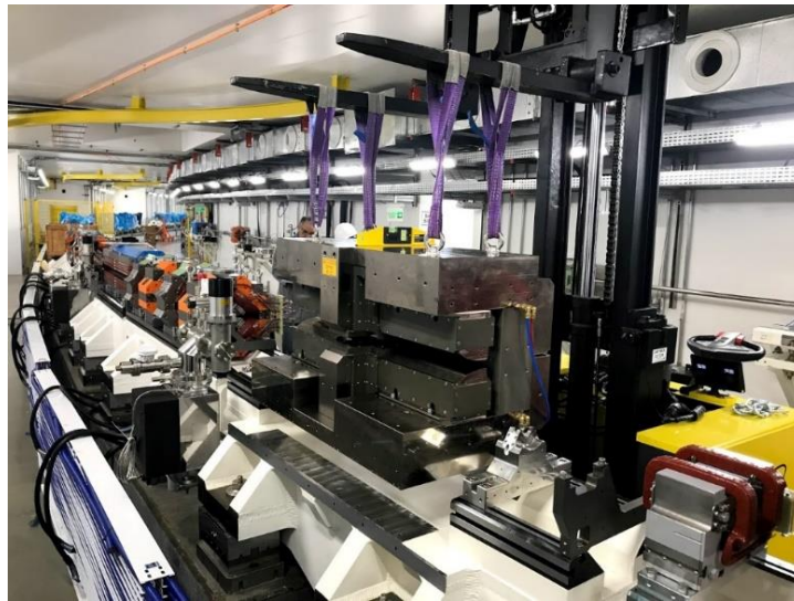
Figura 48. Dipolo BC (magneto permanente) em instalação no Sirius
