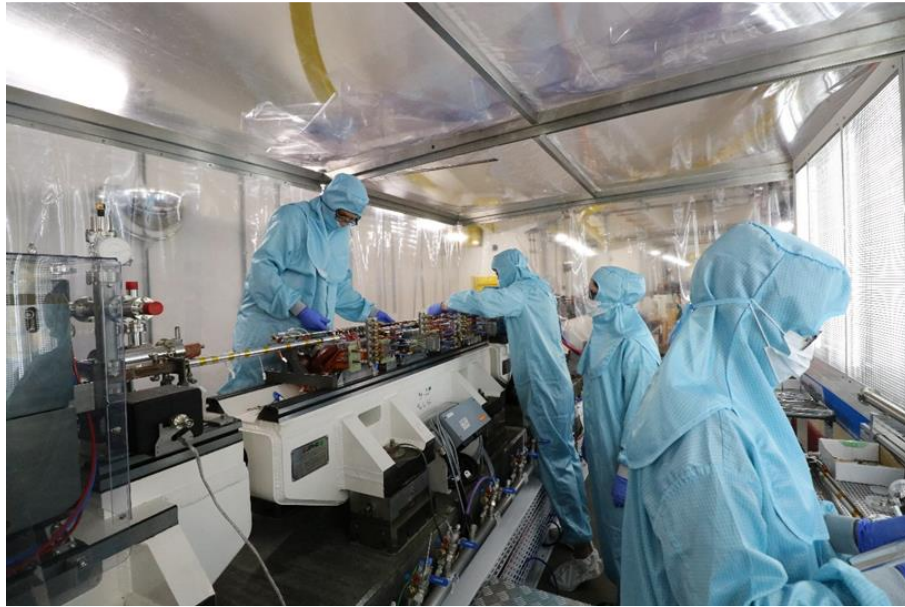
Figura 26. Equipe de vácuo montando as câmaras de um dos setores do anel do Sirius
