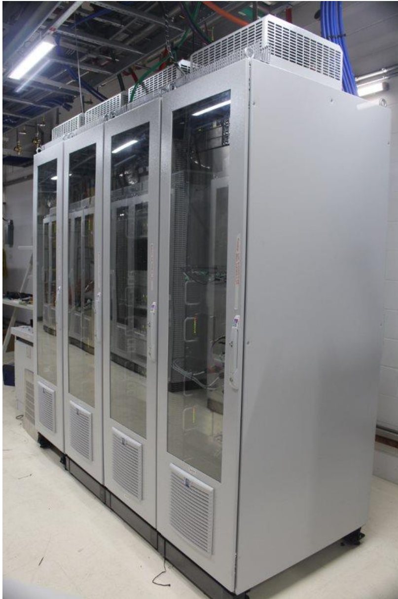
Figura 91. Fontes de sextupolos e quadrupolos do Booster
