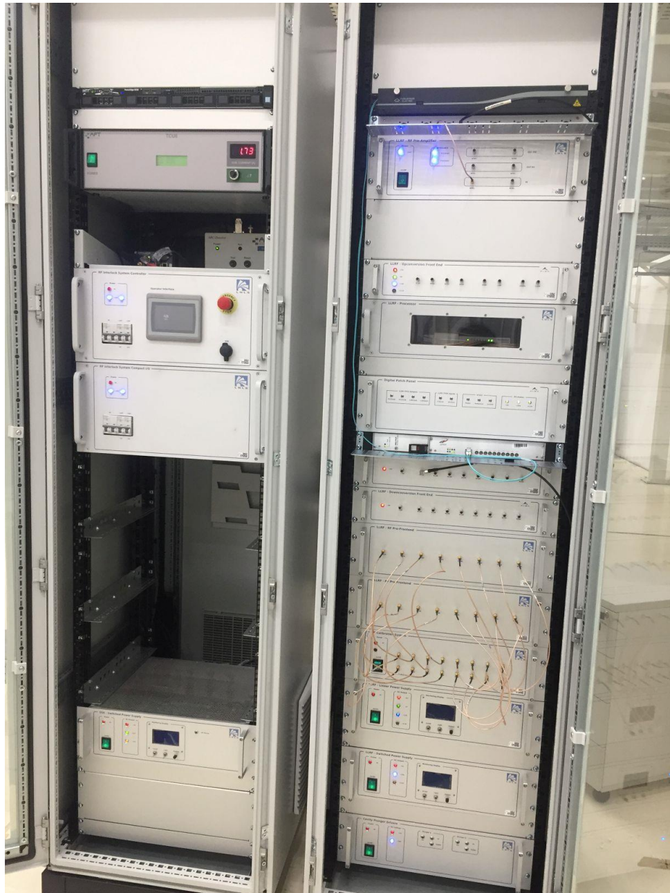
Figura 85. Armários dos circuitos de intertravamento (esquerda) e do LLRF, o sistema de controle de amplitude e fase do campo elétrico acelerador na cavidade de RF (direita)
