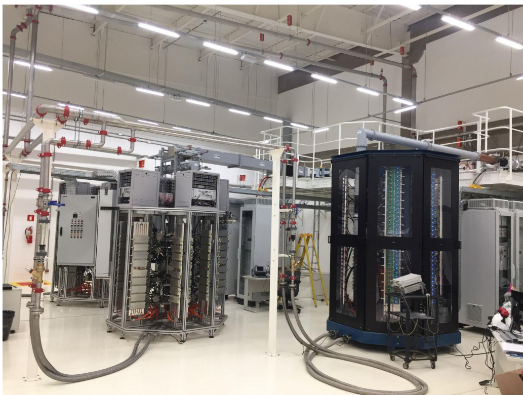
Figura 79. Vista da sala de RF, com o sistema de RF do anel de armazenamento à esquerda, e o sistema do booster à direita
