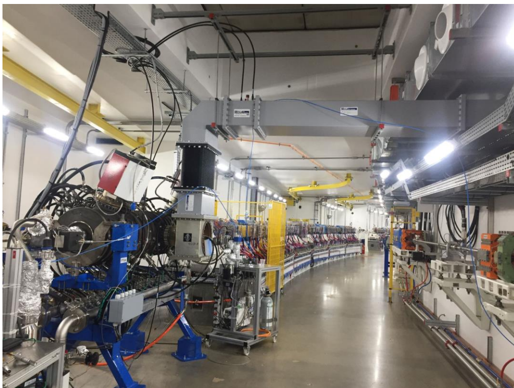
Figura 78. Caverna do anel de armazenamento instalada no túnel, conectada ao sistema de guias de onda
