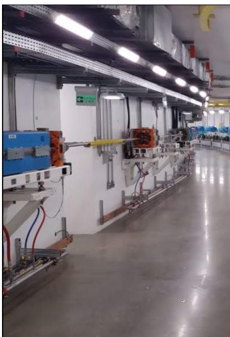
Figura 47. Booster completo e instalado na parede interna já em operação
