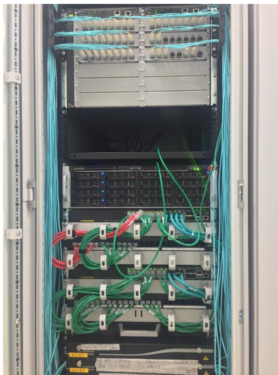
Figura 71. Rack da Sala de Conectividade do Sirius, com switch core e um dos servidores
