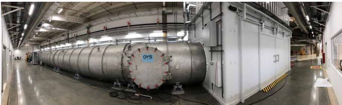
Figura 86. Vista panorâmica da cabana C e túnel de vácuo de espalhamento de raios-X (30 m) da linha CATERETÊ instalados. O Detector de área \pi -MEGA 540 em fabricação será instalado dentro deste túnel, que já tem os trilhos e mesas de movimentação instalados internamente.
