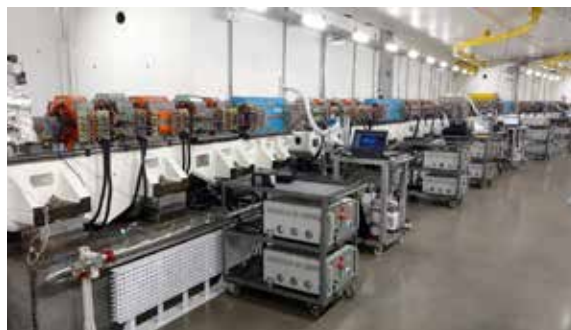
Figura 52. Trecho montado e com o sistema de aquecimento em posição para o início do processo de ativação dos filmes NEG
