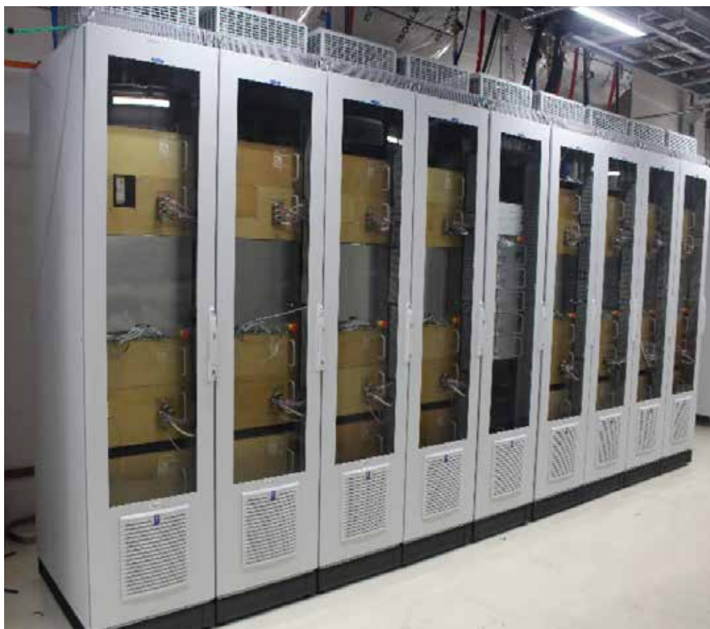
Figura 80. Uma das fontes de dipolos do Booster já instaladas
