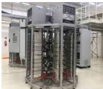
Figura 75. Sistema de RF do Anel de Armazenamento em fase de montagem dentro da sala de RF do Sirius
