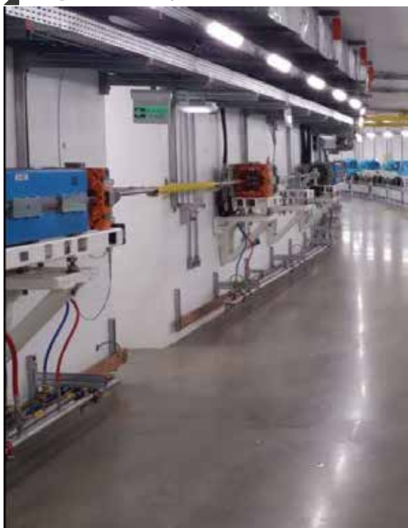
Figura 66. Booster completo e instalado na parede interna já em testes de subsistemas
