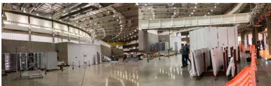
Figura 92. Cabana A da linha CARNAÚBA instalada (esq.) e cabana B (dir.) em montagem
