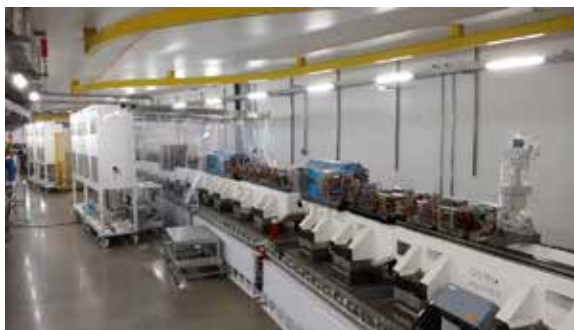
Figura 51. Trecho isolado e com as cabines limpas de montagem posicionadas
