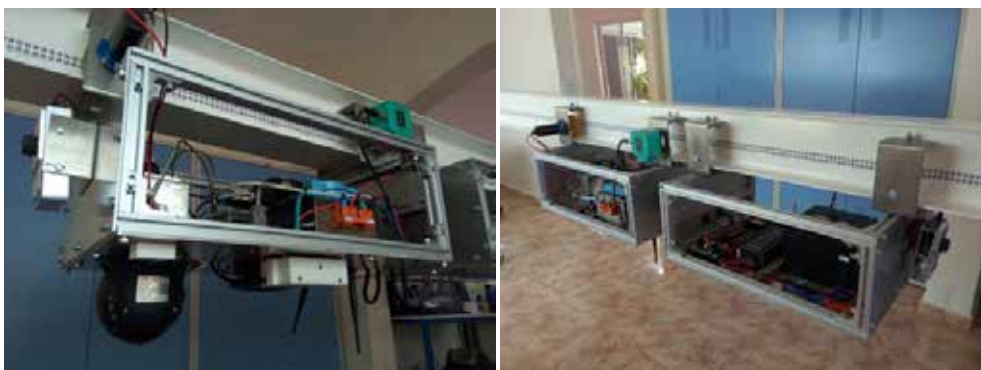
Figura 108. Imagens do Trem de Monitoramento de Túnel (TMT)
