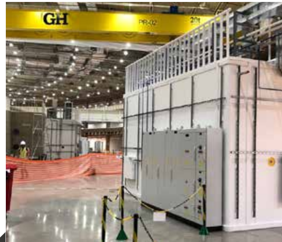
Figura 85. Vista panorâmica das cabanas A e B da linha CATERETÊ instaladas
