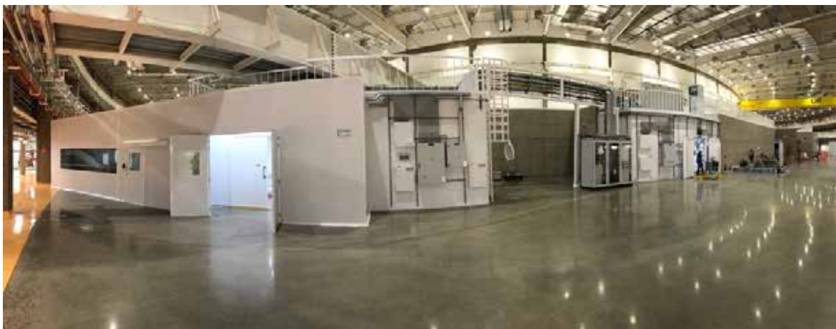
Figura 84. Vista panorâmica das cabanas e utilidades da linha MANACÁ instaladas
