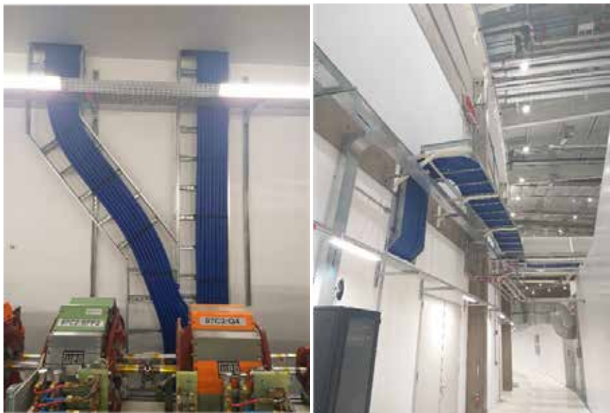
Figura 99. Infraestrutura para cabeamento das fontes de potência
