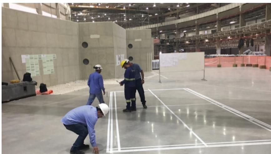
Figura 40. Início das marcações para instalação das cabanas da linha MANACÁ no Sirius.
