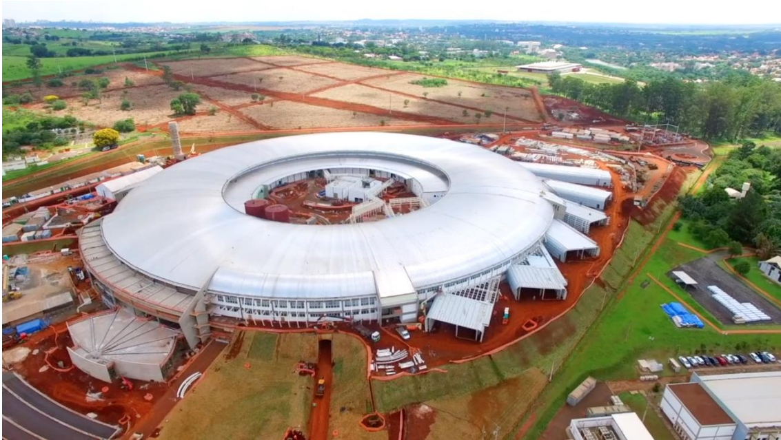
Figura 87: Vista Aérea das obras civis em dezembro de 2016 (superior), junho de 2017 (centro) e novembro e dezembro de 2017 (duas últimas inferiores).
