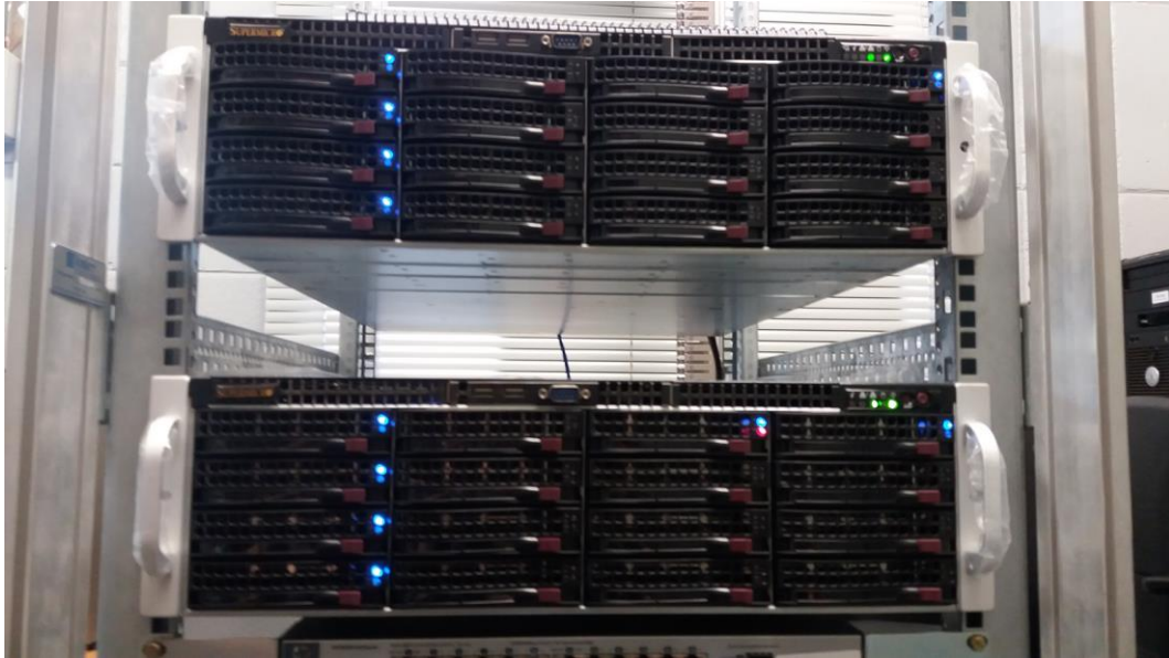
Figura 0.35: Servidores que hospedarão importantes serviços do sistema de controle do Sirius.
