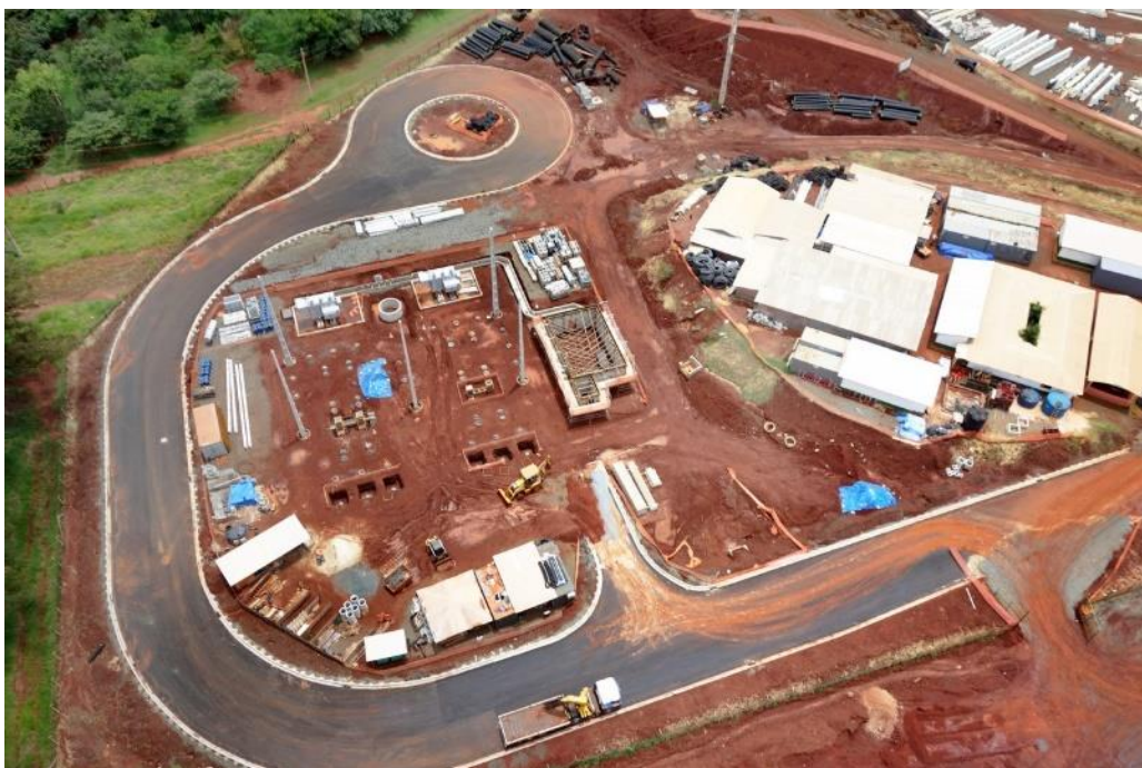
Figura 86: Vista Aérea da Subestação de AT.
