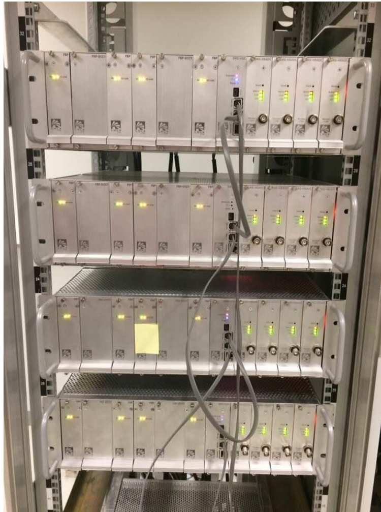
Figura 0.59. Quatro bastidores de fontes FBP do lote piloto sendo testadas.
