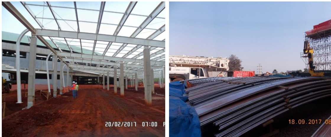
Figura 82: Estrutura Metálica das Linhas Longa (Esquerda) e fabricação da cobertura da edificação.
