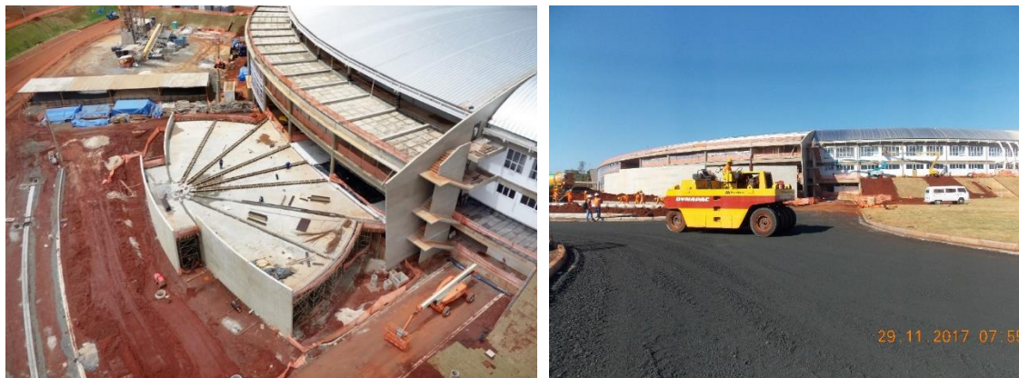
Figura 85: Estrutura do Auditório (esquerda) e Pavimentação (direita).
