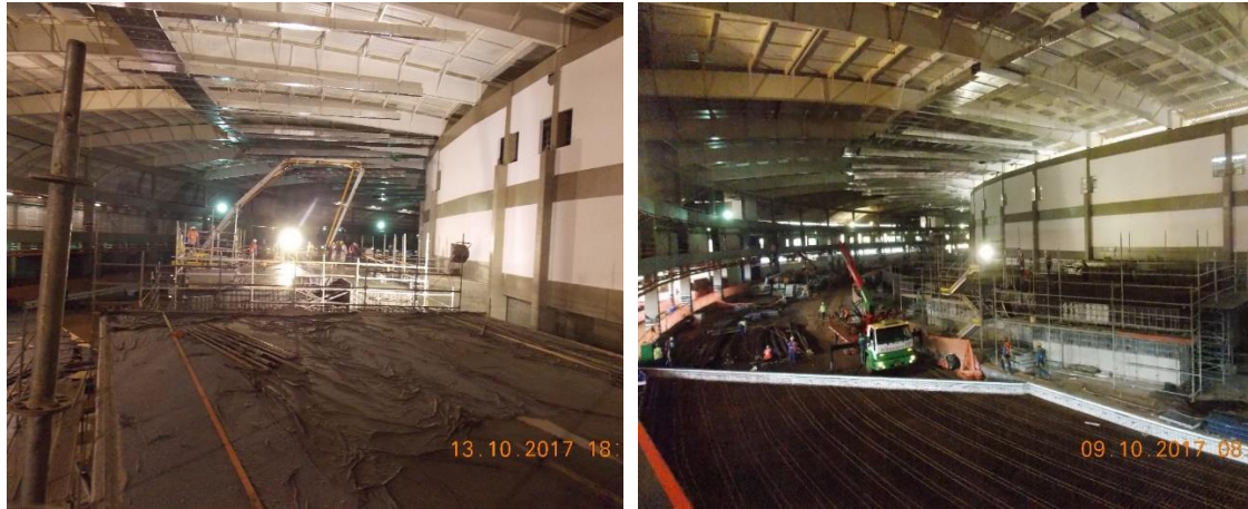
Figura 84: Concretagem da blindagem do túnel dos aceleradores.
