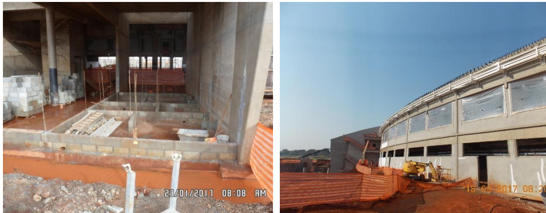
Figura 81: Execução de alvenaria Interna e externa.
