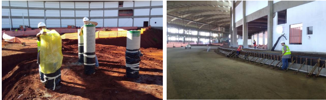
Figura 0.25: Esquerda: Monumentos centrais de alinhamento do Sirius. Direita: Verificação de nível das juntas metálicas do piso especial.
