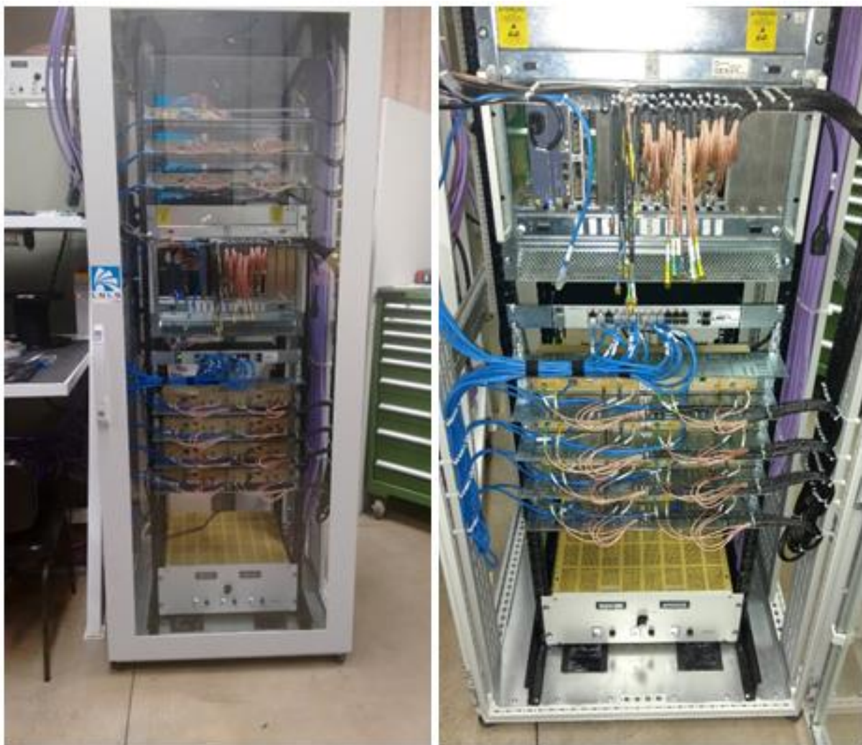
Figura 0.40. Rack protótipo montado em parceria com a empresa Atmos Sistemas que permitiu que equipamentos de suporte fossem definidos, passagem dos cabos e montagens fossem definidos e documentados, para posterior reprodução em série.
