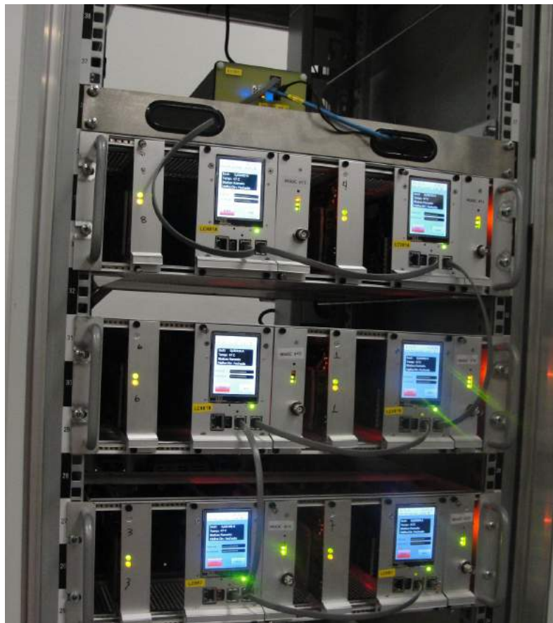
Figura 1.6.203 Novas fontes de corrente instaladas no acelerador linear. As fontes são protótipos das fontes de corretores de órbita do Sirius, com regulação e controle digitais. Acima das fontes o nó da rede de controle do U VX conectado às fontes por uma rede serial.
