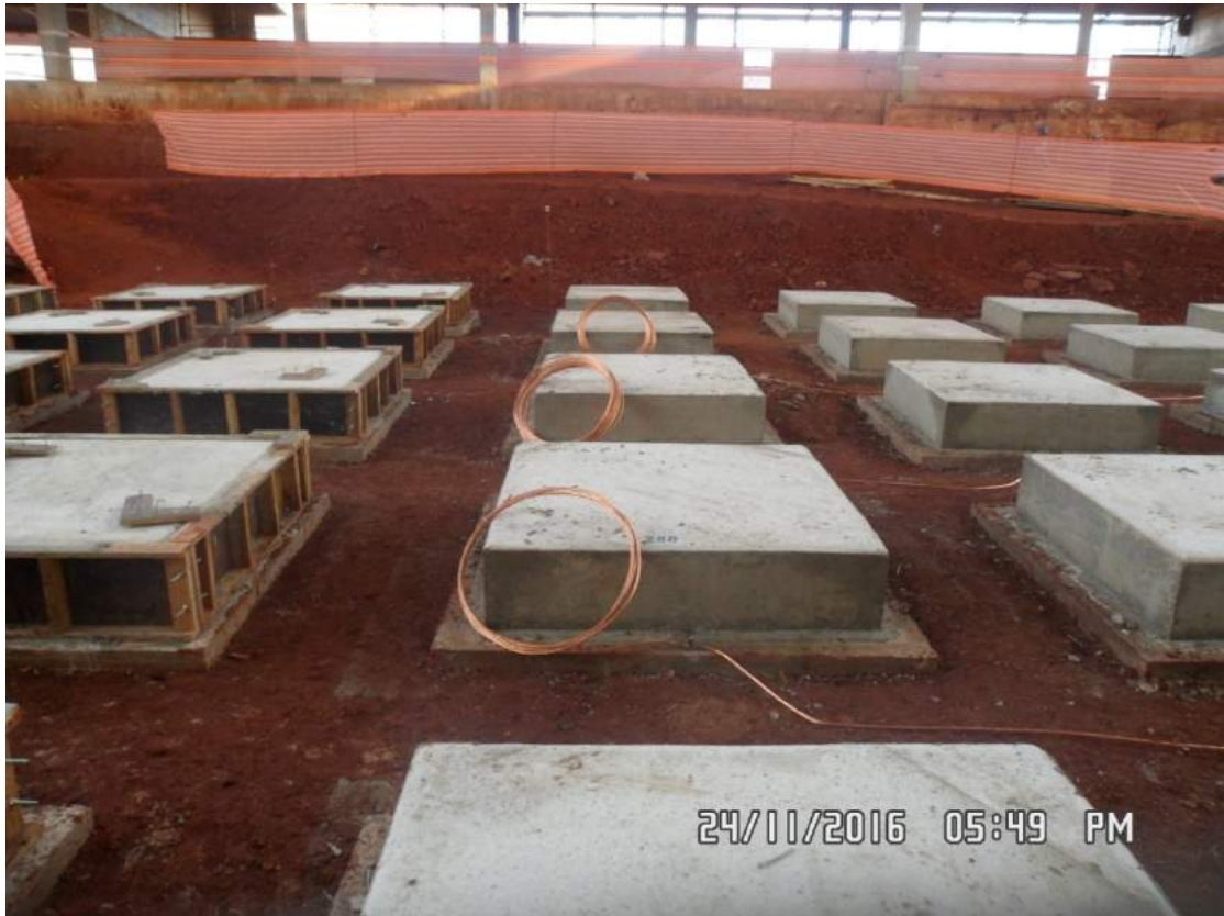
Figura 1.7.119 Início da preparação do piso especial com as seguintes etapas - Execução do aterramento.
