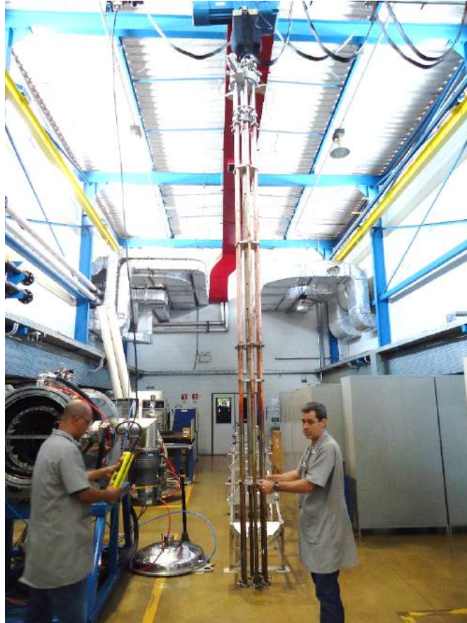
Figura 1.7.12. Cartucho com 6 câmaras sendo içado para inserção no sistema de deposição NEG.
