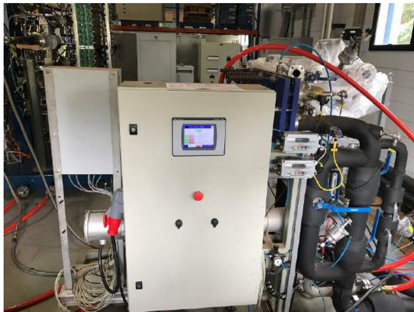
Figura 1.7.30: Nova bancada de testes hidráulicos para validação dos sistemas de refrigeração dos magnetos.
