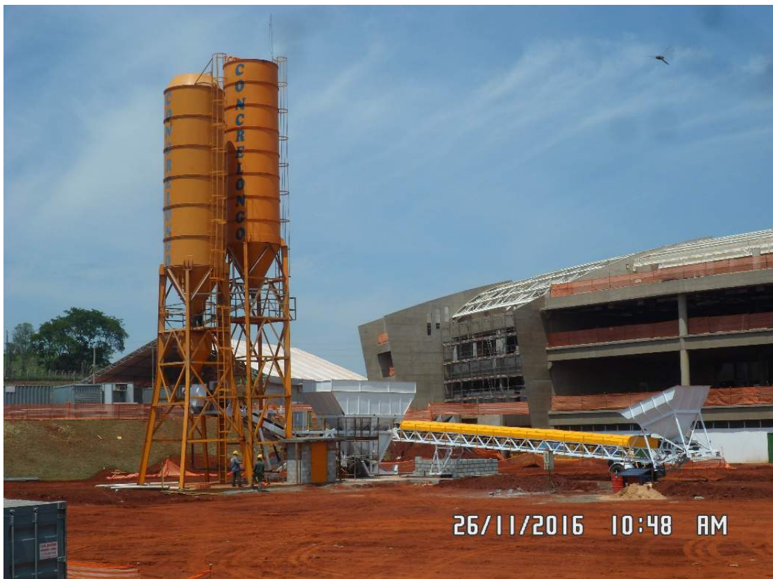
Figura 1.7.120 Implantação da Usina de Concreto. Início de construção do Reservatório de Água Elevado – Estrutura.
