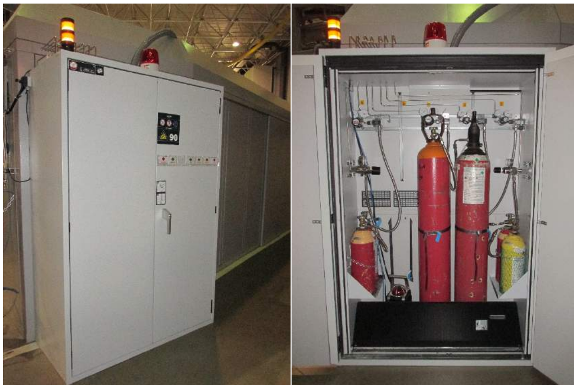
Figura 1.7.76 Sistema de armazenamento e distribuição de gases com interlock de segurança que será padrão no Sirius e permite trabalhar com gases de alta concentração com maior segurança.
