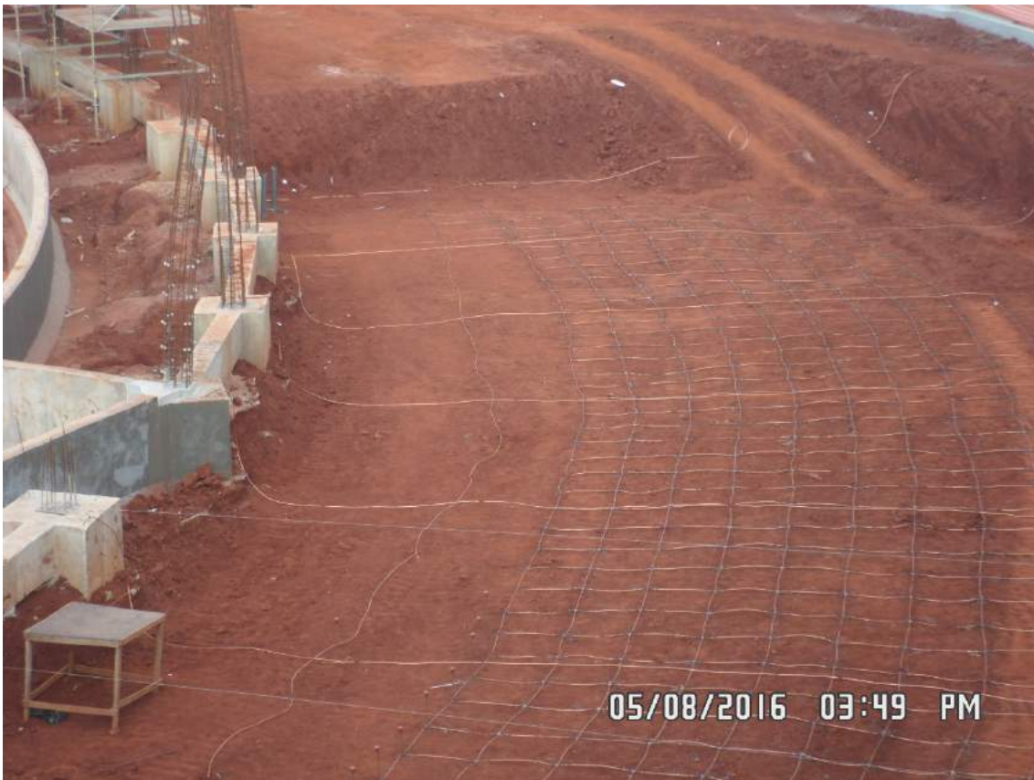
Figura 1.7.109 Infraestrutura Enterrada Parcial - Média tensão.
