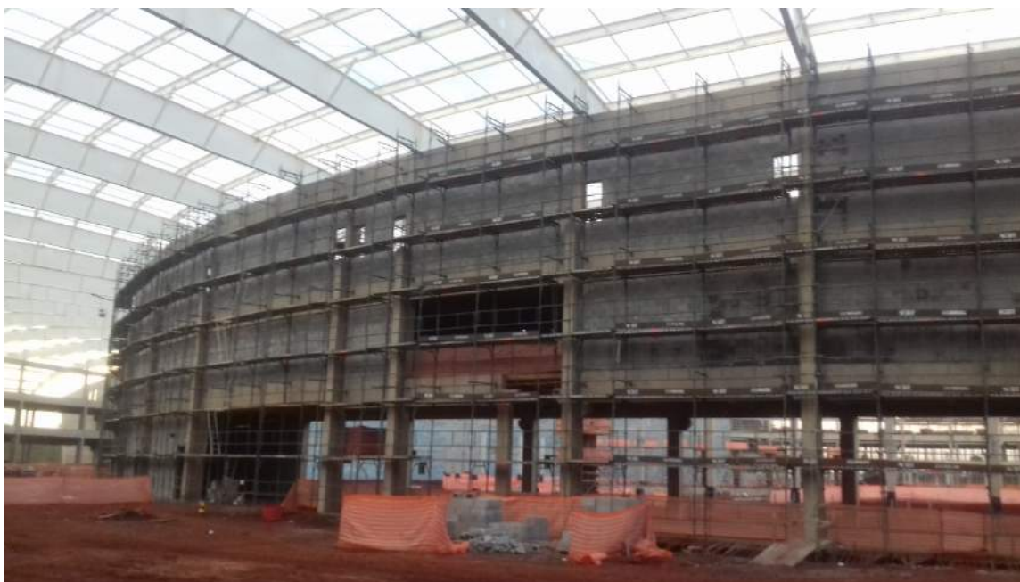
Figura 1.7.107 - Alvenaria de Vedação da Edificação Principal.
