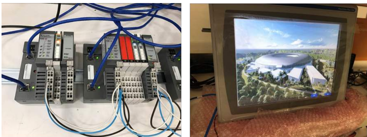
Figura 1.7.70. Módulo remoto para proteção pessoal e IHM em desenvolvimento para o sistema de intertravamento
