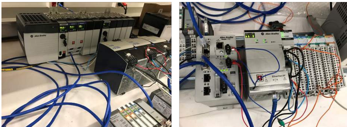
Figura 1.7.69. CLP central e módulo remoto do sistema de intertravamento do Sirius.
