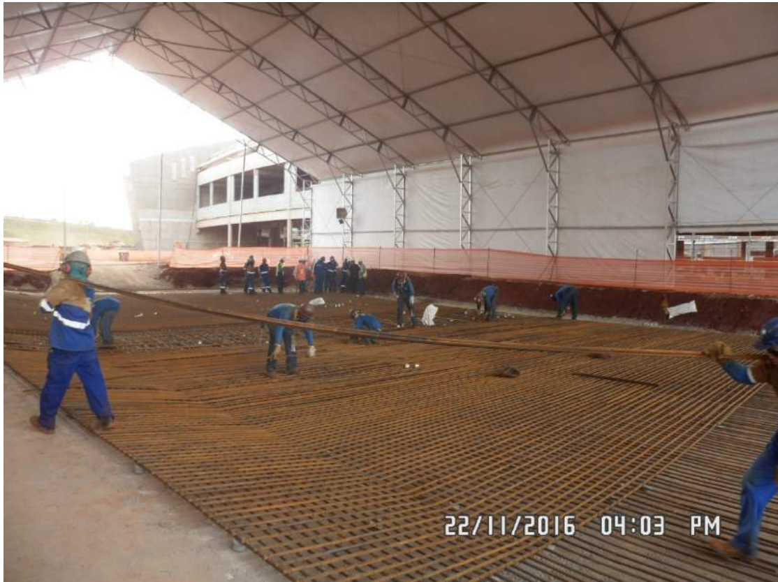
Figura 1.7.115 Execução de três protótipos de piso especial (um em tamanho real) e acompanhamento do comportamento térmico e dimensional - Placa III.
