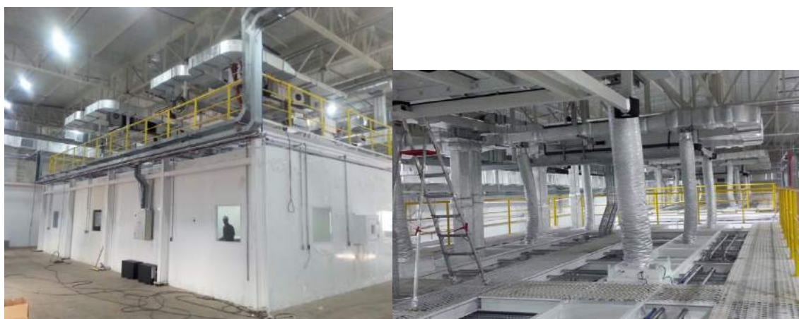
Figura 1.7.86 Laboratório de metrologia ótica e mecânica com suas salas de ambiente controlado, e detalhe dos sistemas de condicionamento de ar e sala de máquinas
