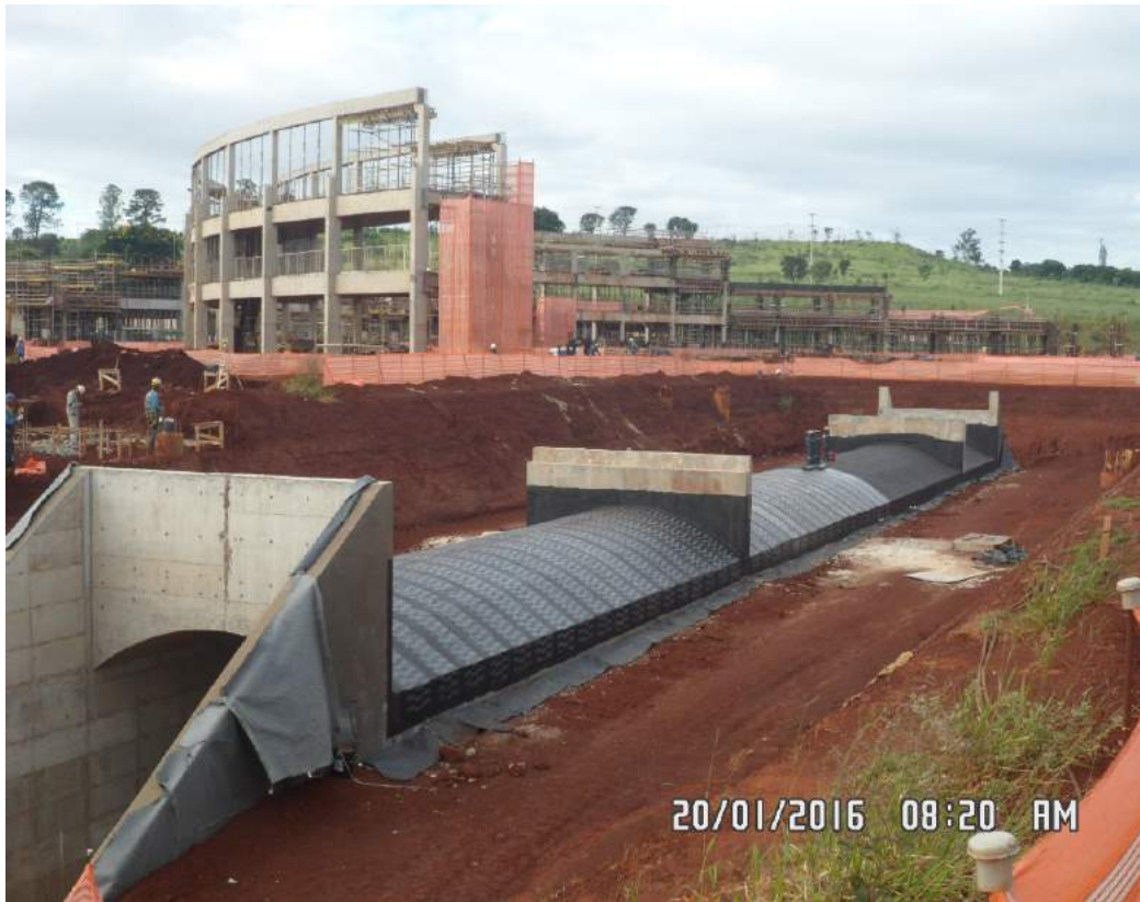
Figura 1.7.106 Impermeabilização e Reaterro do Túnel de Acesso.
