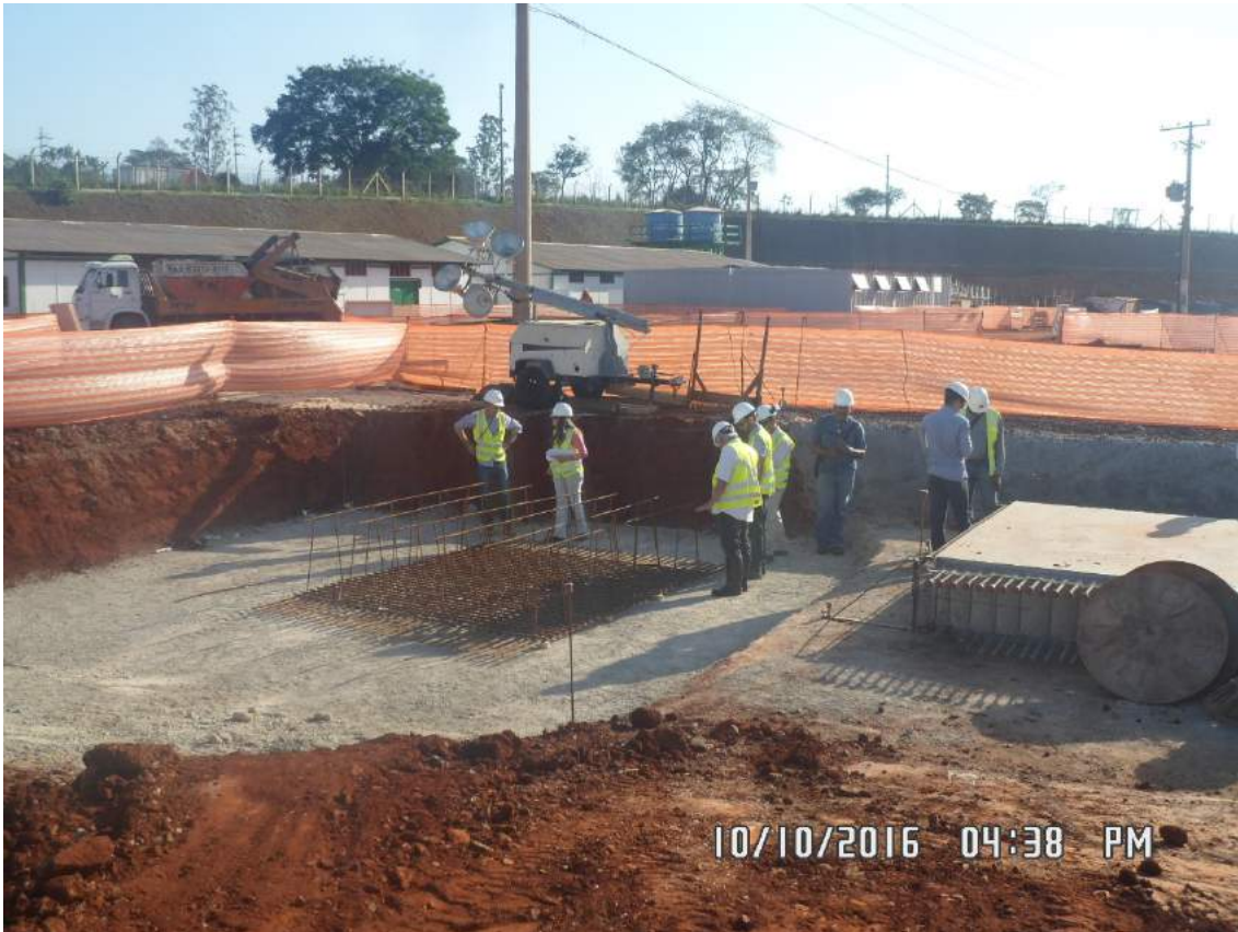
Figura 1.7.114 Execução de três protótipos de piso especial (um em tamanho real) e acompanhamento do comportamento térmico e dimensional - Placa II.
