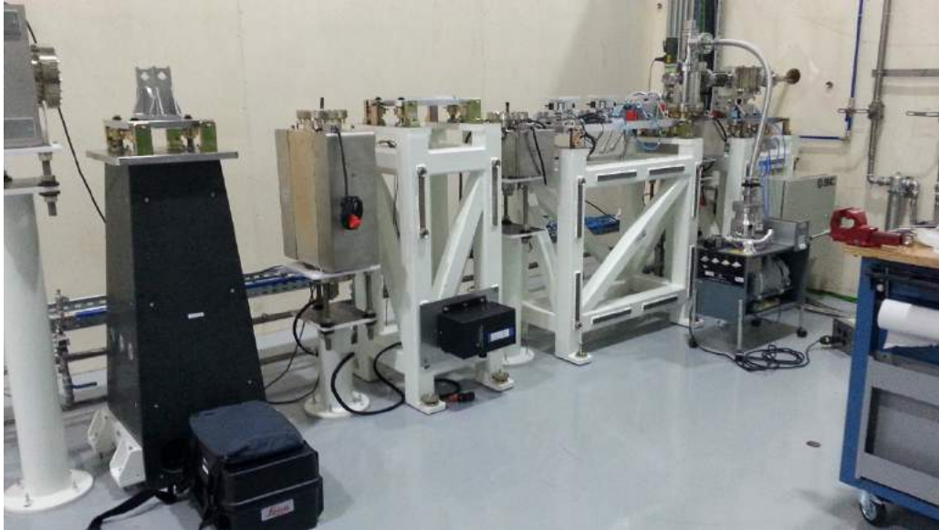
Figura 1.7.79 Front-end em montagem no prédio de metrologia.
