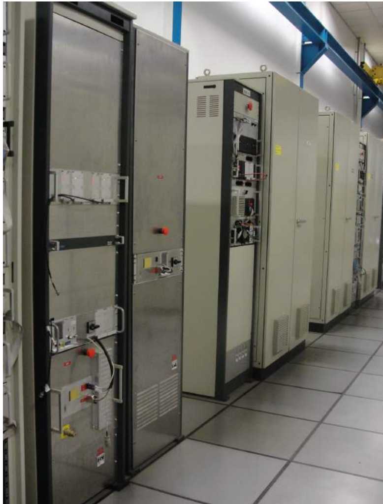
Figura 1.6.21 À esquerda os dois armários da nova fonte de sextupolos que testa conceito que será utilizado no Sirius para as fontes de maior potência. A fonte em testes ocupa a metade inferior do armário. O da esquerda abrigará no futuro todas as três fontes de sextupolos do UVX, a da direita é o retificador que alimentará as três fontes. Ao fundo o conjunto de armários das três fontes de sextupolos originais do UVX.
