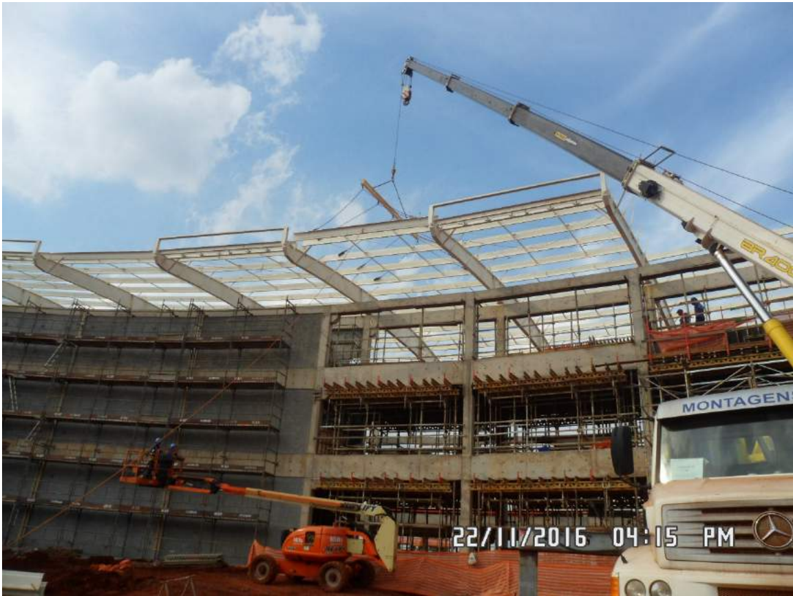
Figura 1.7.108 Fabricação e instalação da Estrutura Metálica da Edificação Principal.
