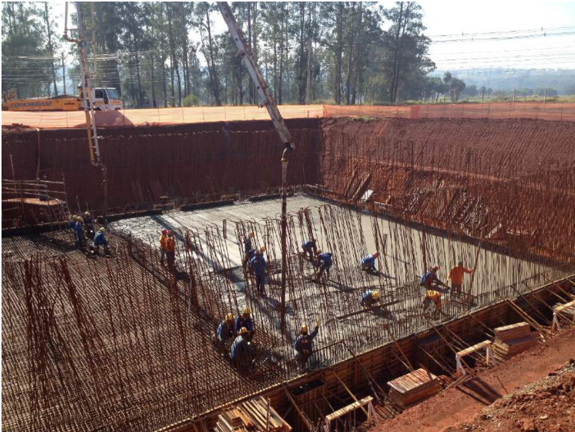
Figura 1.7.110 Execução Parcial dos Tanques de Retardo de Água Pluviais.
