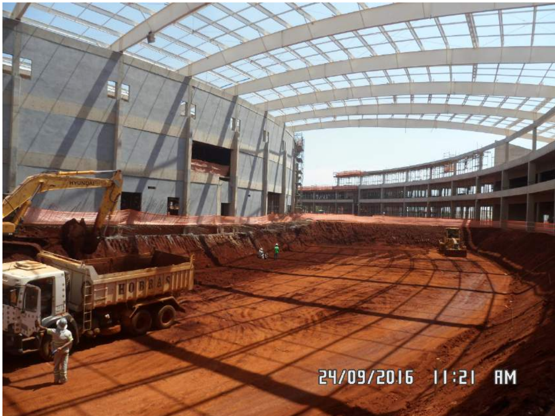
Figura 1.7.116 Início da preparação do piso especial com as seguintes etapas – Escavação.
