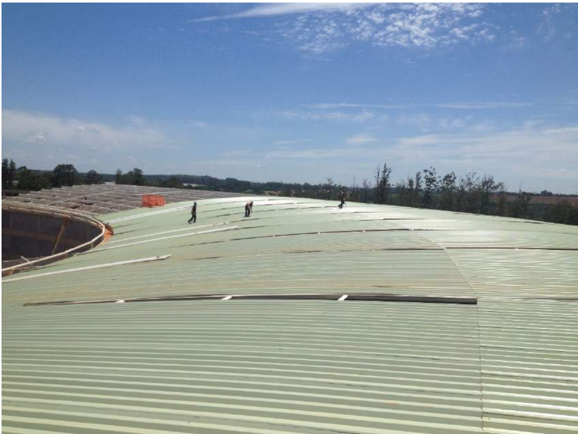
Figura 1.7.111 Lançamento da Primeira Telha de Cobertura da Edificação Principal.
