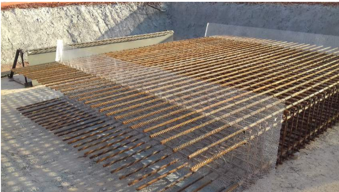
Figura 1.7.113 Execução de três protótipos de piso especial (um em tamanho real) e acompanhamento do comportamento térmico e dimensional – Placa I.
