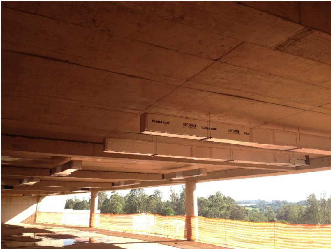
Figura 1.7.112 Início das Instalações de Dutos de Ar Condicionado nos Escritórios.
