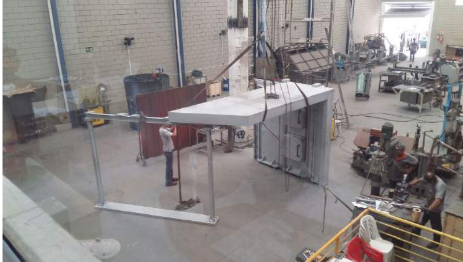
Figura 1.7.74 Vista superior dos elementos de encaixe da cabana ótica protótipo em processo de montagem.
