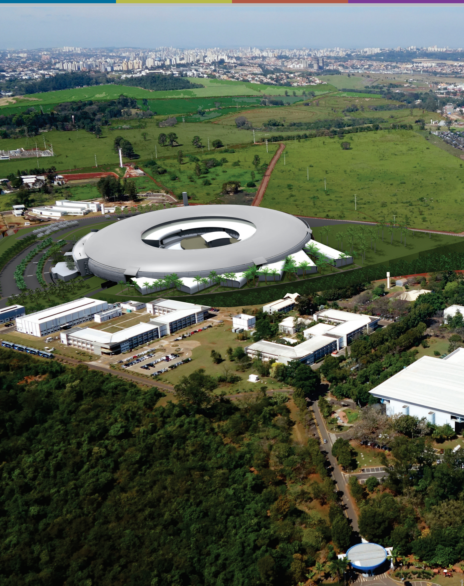
Campus do CNPEM com projeção na nova fonte de Luz Síncrotron, Sirius.
