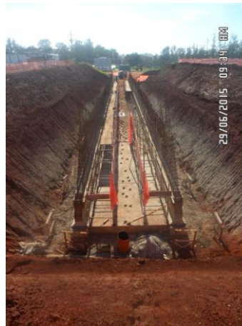
Estágios da construção do túnel de acesso à parte central do edifício mostrando a escavação, perfuração das estacas, arrasamento das estacas, confecção dos blocos, armação do piso e confecção das paredes.
