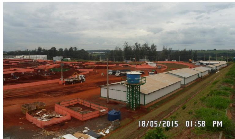
Canteiro de obras.
