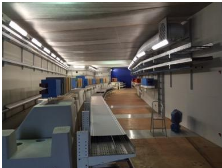
Cruzeiro do Sul: montagem em escala real de um trecho do túnel onde serão instalados o booster e o anel de armazenamento de elétrons do Projeto Sirius.
