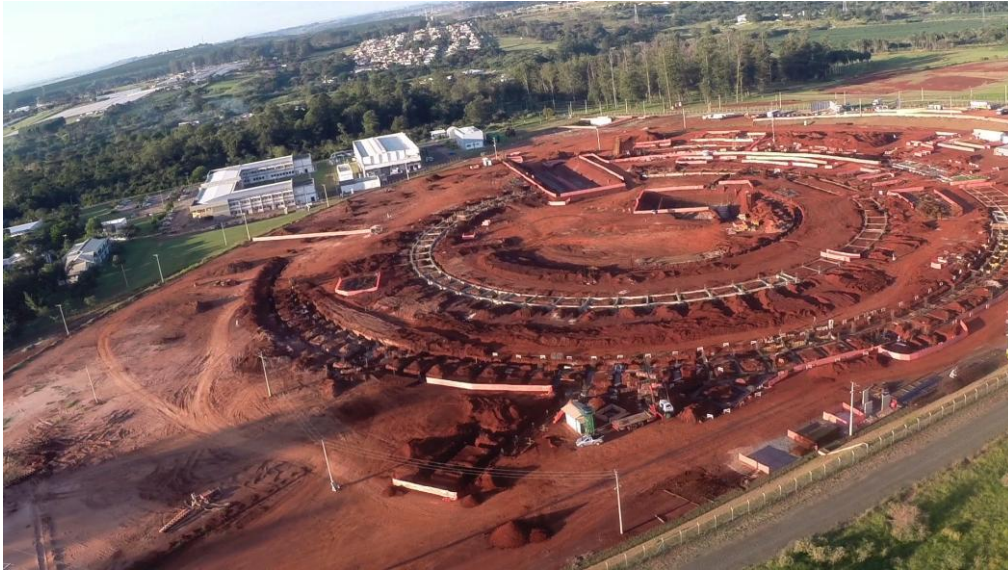
Vista Aérea - Situação em 26/06/2015.
