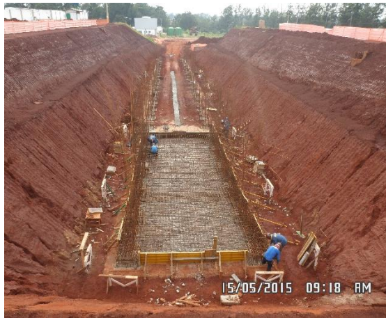
Estágios da construção do túnel de acesso à parte central do edifício mostrando a escavação, perfuração das estacas, arrasamento das estacas, confecção dos blocos, armação do piso e confecção das paredes.
