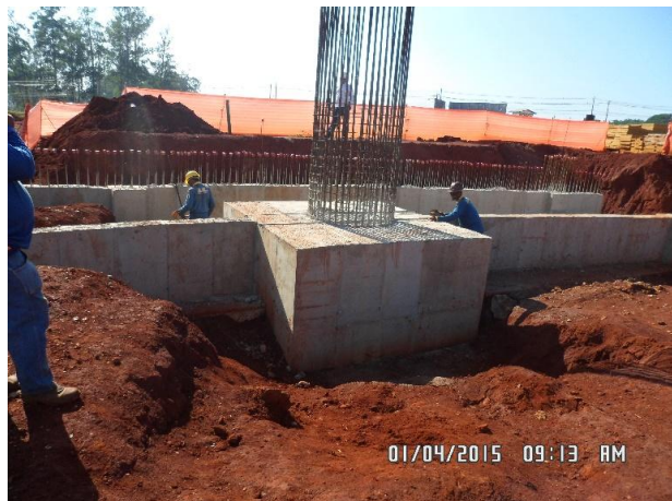
Detalhes da fundação: Blocos e baldrames.
