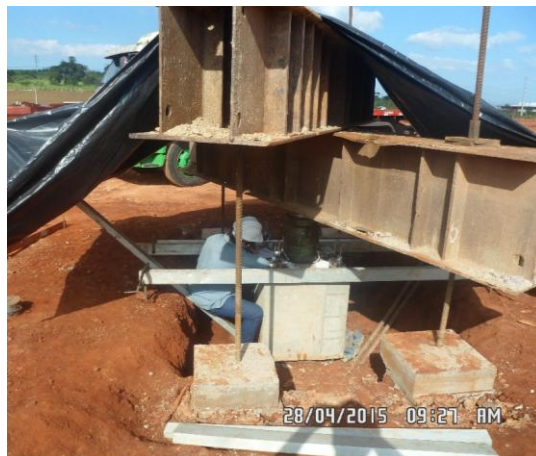
Perfuração da primeira estaca e prova de carga estática.
