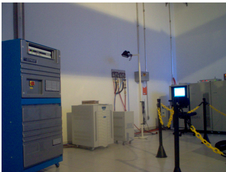
Figura 23: Infra-estrutura do “Cryo-Probe”.
