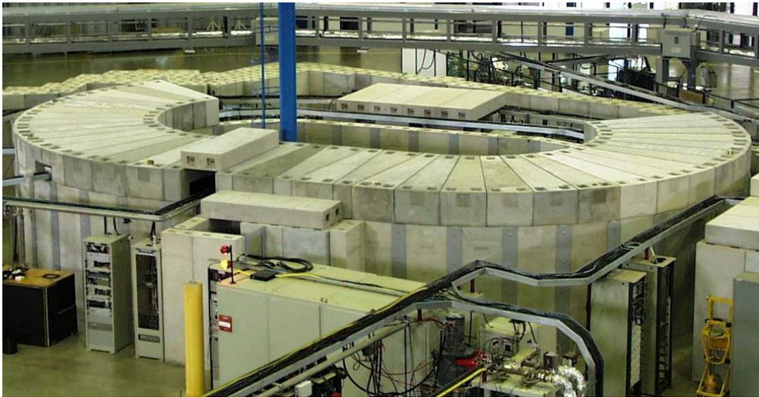
**Figura 3: O síncrotron injetor de 500 MeV após instalação da cobertura de concreto.**
