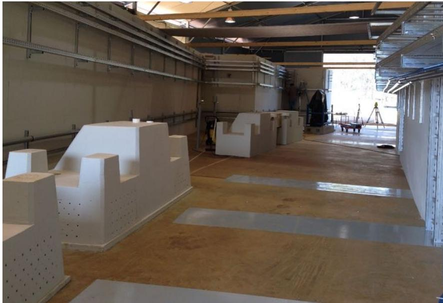
*2. 65 – Cruzeiro do Sul: montagem em escala real de um trecho do túnel onde serão instalados o booster e o anel de armazenamento de elétrons do Projeto Sirius.*
