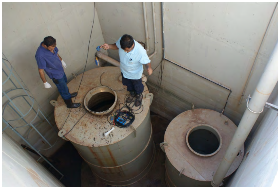
Figura 65 – Estações de Tratamento de esgoto
