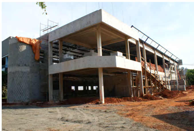
Figura 61 – Obras do novo prédio do LNLS
