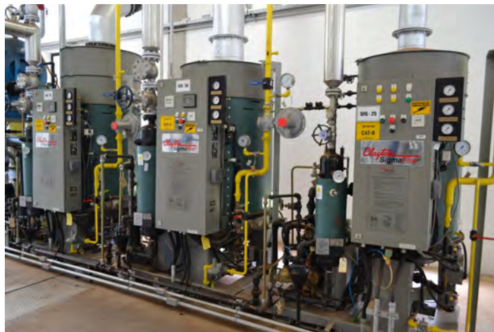
Figura 38 - Caldeiras para geração de vapor saturado
