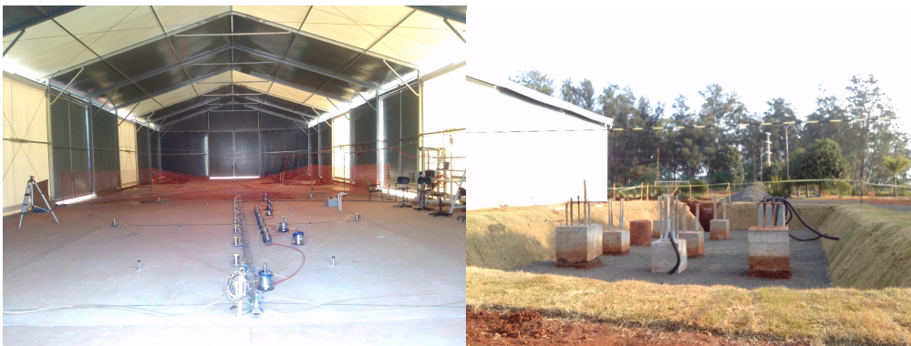
Instalações construídas especialmente para ensaios dinâmicos de dois tipos de protótipos de piso para o Sirius (esquerda) e estacas (direita)
