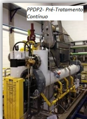
Figura 4.7 – PPDP2: Unidade de Pré-Tratamento Contínuo
