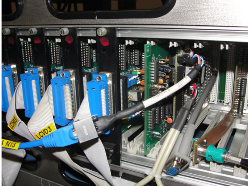
Figura 2.3: Bastidor do sistema de controle das fontes de ímãs de correção de órbita do Linac mostrando as placas de conversão AD/DA à esquerda e a SBC à direita. O Linac é totalmente controlado pela nova rede SBC/ethernet
