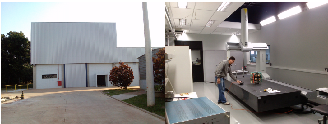
Figura 2.8: Edifício de laboratórios concluído e ocupado em 2013 (à direita sala de metrologia)
